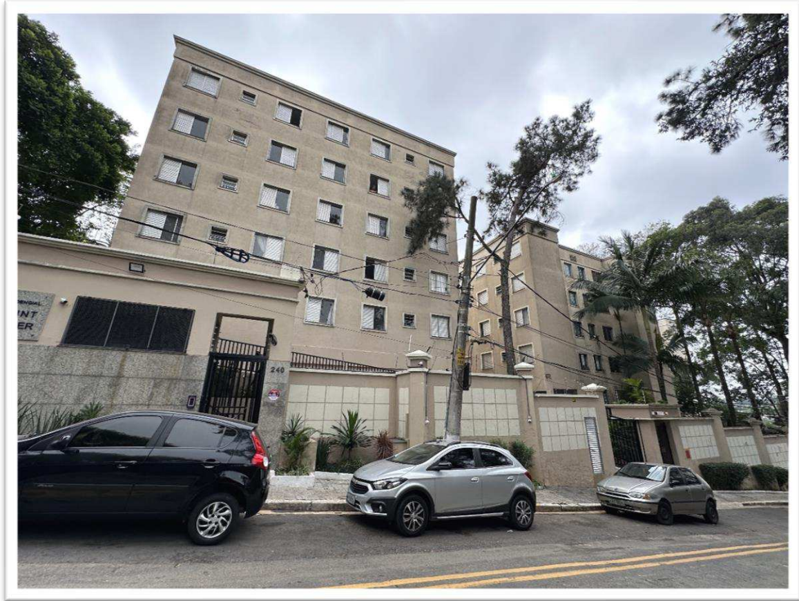
Figura 3 - Vista frontal do Condomínio Saint Peter
