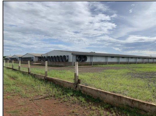
Figura 13 - Aspecto geral do imóvel avaliando
