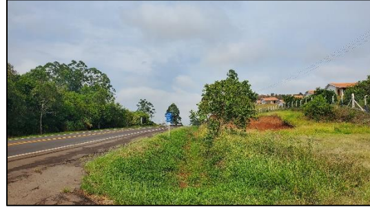
Figura 53 - Aspecto da rodovia de acesso ao imóvel avaliando
