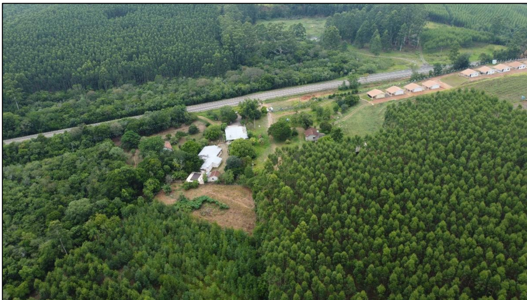
Figura 50 - Imagem aérea do imóvel avaliando
