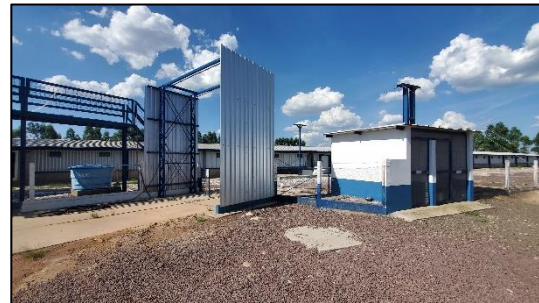
Figura 118 - Aspecto geral do imóvel avaliando
