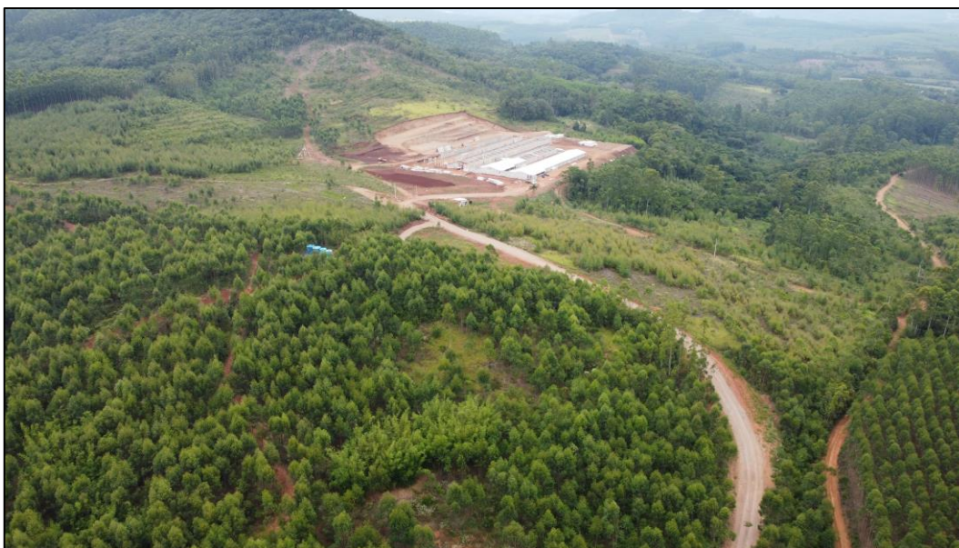
Figura 89 - Imagem aérea do imóvel avaliado
