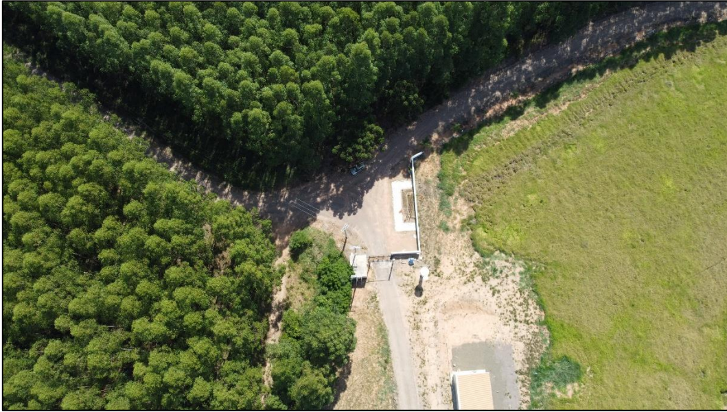
Figura 108 - Aspecto geral da entrada do imóvel avaliando
