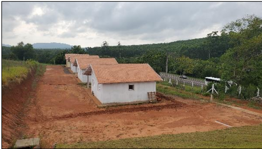
Figura 60 - Aspecto geral das benfeitorias do imóvel avaliando
