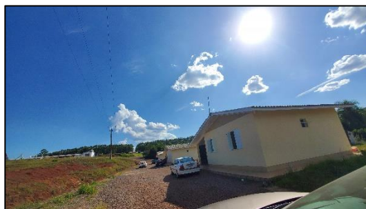
Figura 122 - Aspecto geral das residências dos funcionários do imóvel avaliando
