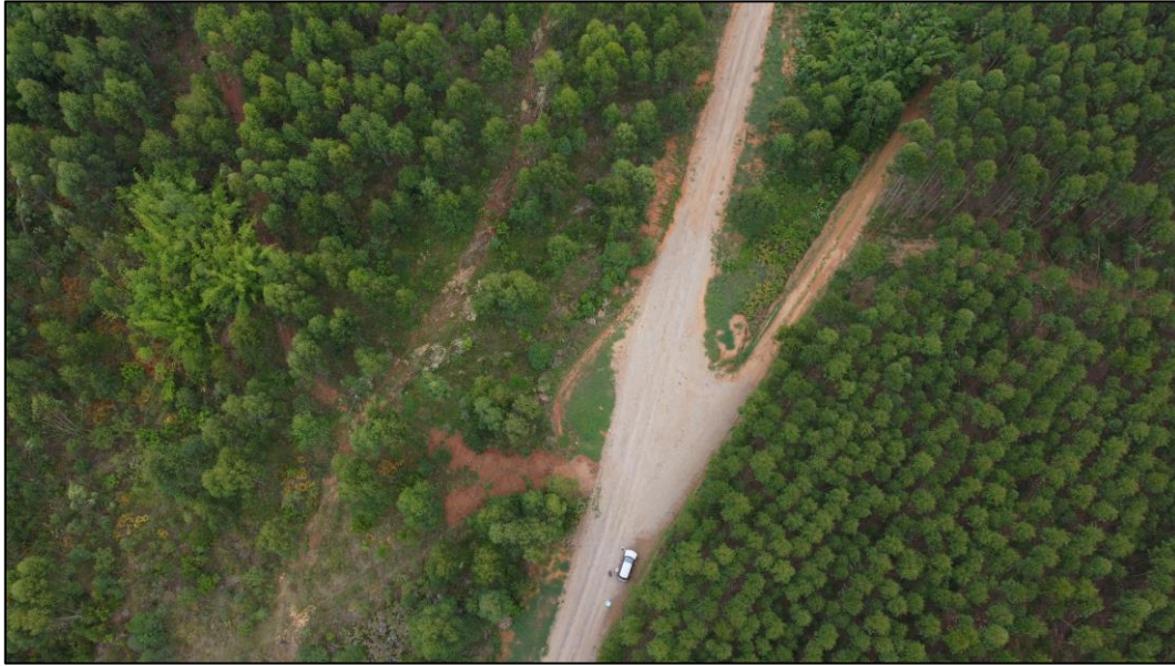
Figura 90 - Imagem aérea do acesso do imóvel avaliando
