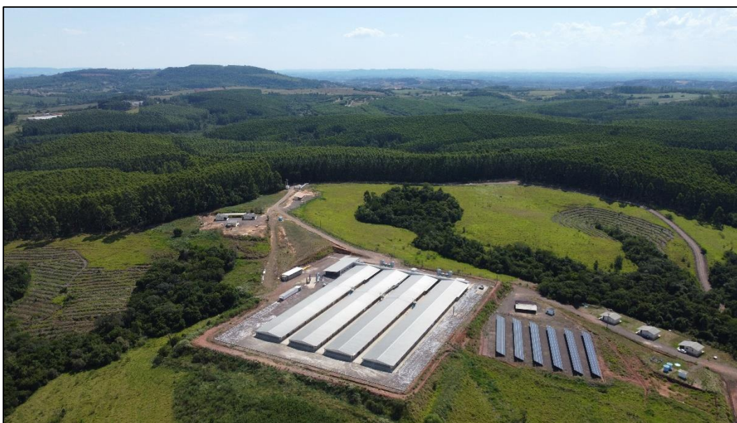
Figura 105 - Imagem aérea do imóvel avaliado
