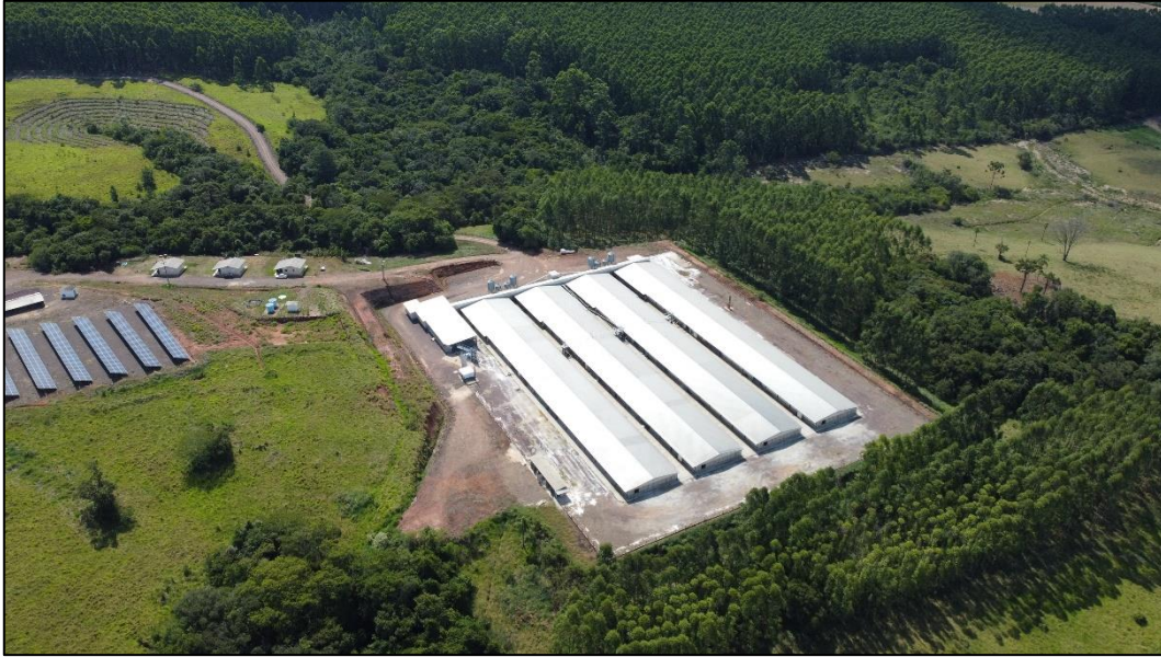
Figura 106 - Imagem aérea do imóvel avaliando
