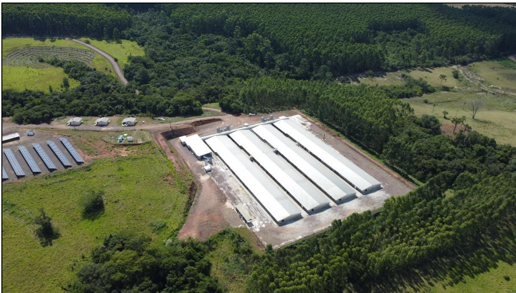
Figura 107 - Imagem aérea do imóvel avaliando
