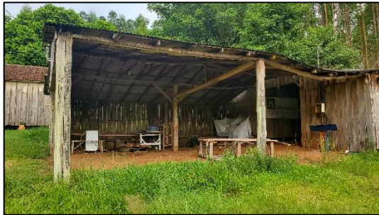
Figura 54 - Aspecto geral das benfeitorias do imóvel avaliando
