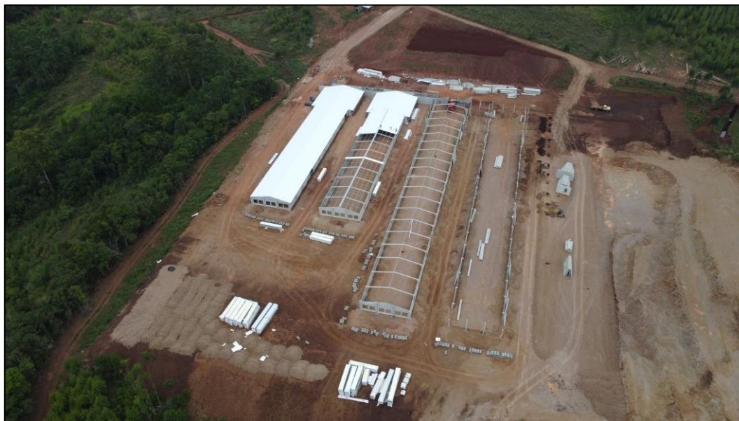
Figura 92 - Aspecto geral das benfeitorias em fase de construção
