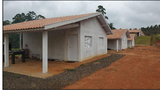
Figura 59 - Aspecto geral das benfeitorias do imóvel avaliando
