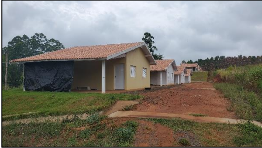
Figura 58 - Aspecto geral das benfeitorias do imóvel avaliando
