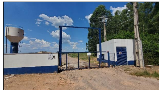
Figura 114 - Aspecto geral do portão de entrada do imóvel avaliando
