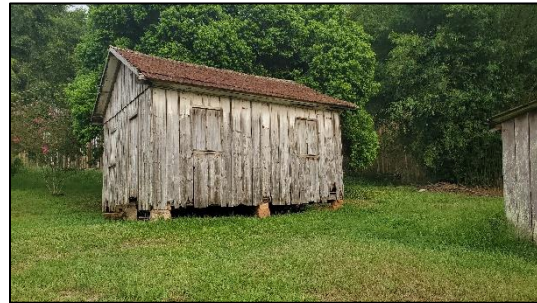
Figura 55 - Aspecto geral das benfeitorias do imóvel avaliando
