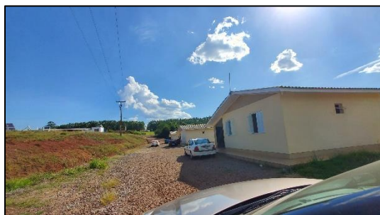
Figura 121 - Aspecto geral das residências dos funcionários do imóvel avaliando
