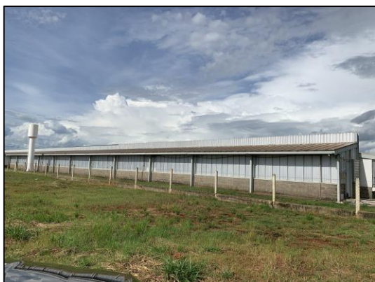
Figura 10 - Aspecto geral do imóvel avaliando
