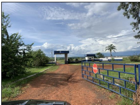
Figura 6 - Aspecto geral da entrada do imóvel avaliando
