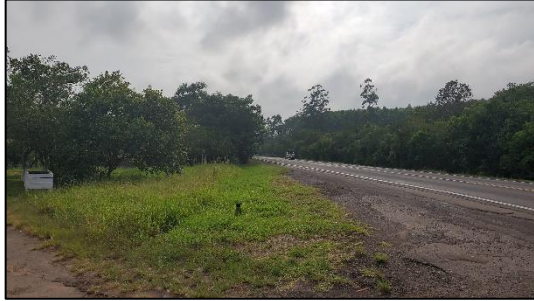
Figura 52 - Aspecto da rodovia de acesso ao imóvel avaliando
