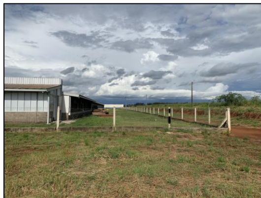
Figura 9 - Aspecto geral do imóvel avaliando
