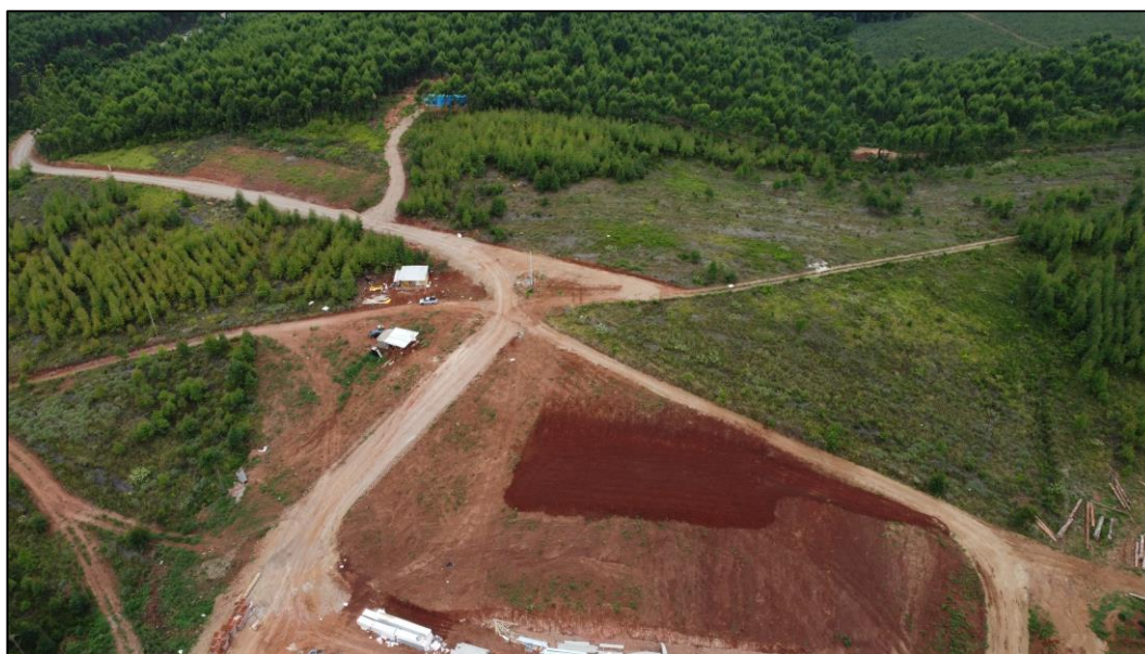
Figura 93 - Aspecto geral do imóvel avaliando
