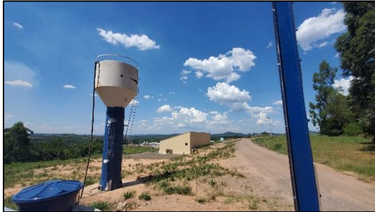
Figura 115 – Aspecto geral do imóvel avaliando
