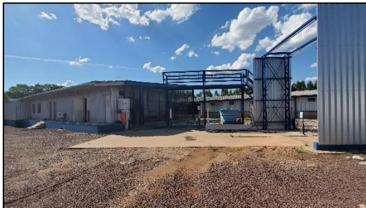
Figura 117 - Aspecto geral do imóvel avaliando
