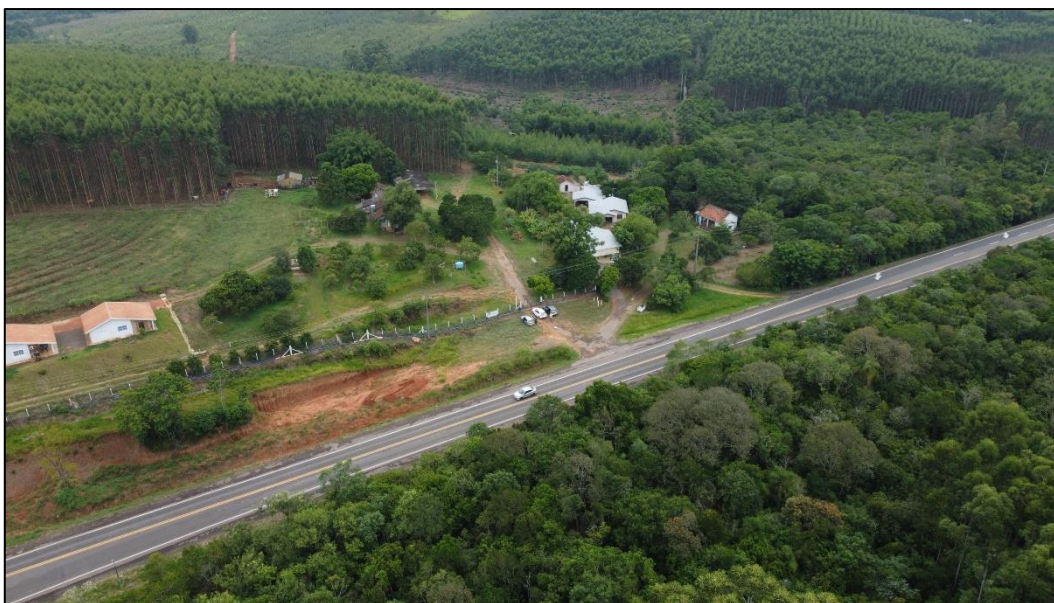
Figura 49 - Imagem aérea do imóvel avaliando
