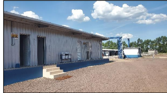
Figura 116 - Aspecto geral do imóvel avaliando
