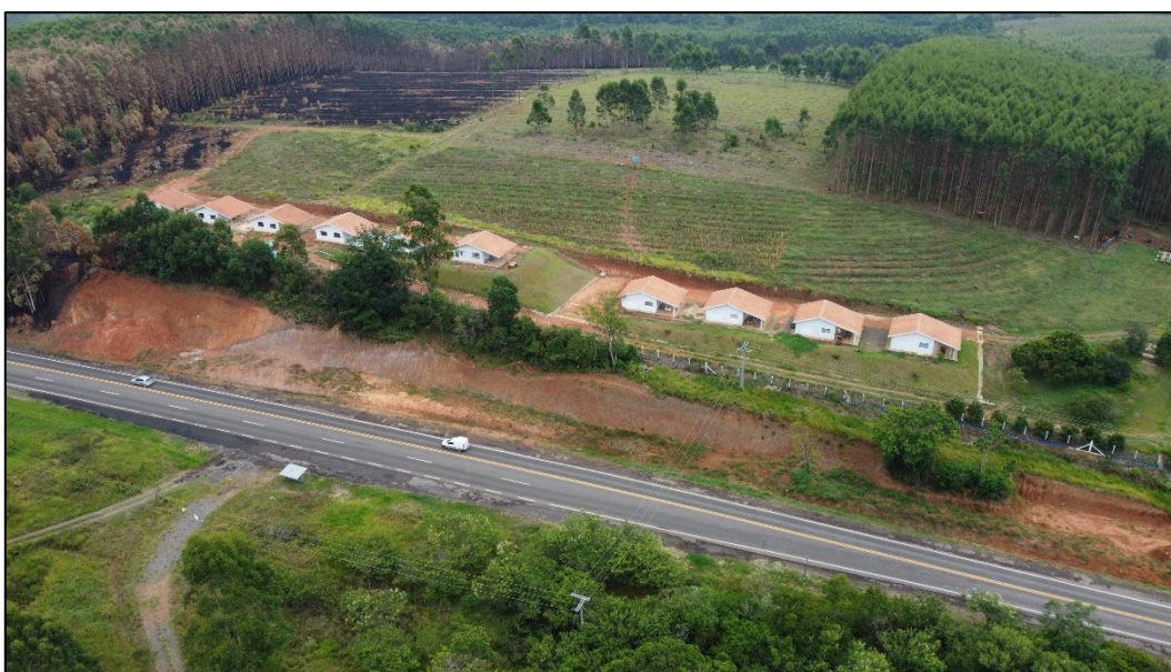
Figura 51 - Imagem aérea do imóvel avaliando
