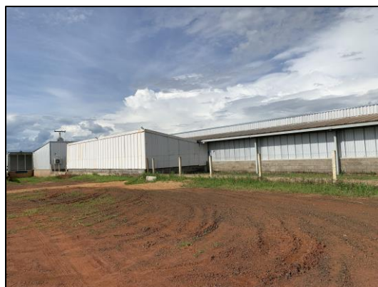
Figura 11 - aspecto geral do imóvel avaliando
