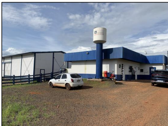
Figura 8 - Aspecto geral do imóvel avaliando
