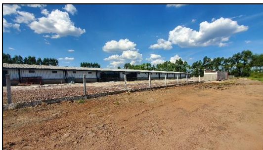
Figura 119 - Aspecto geral do imóvel avaliando
