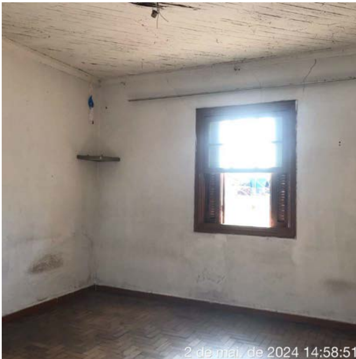
FOTO 6: DORMITÓRIO EDIFICAÇÃO DE Nº 118
