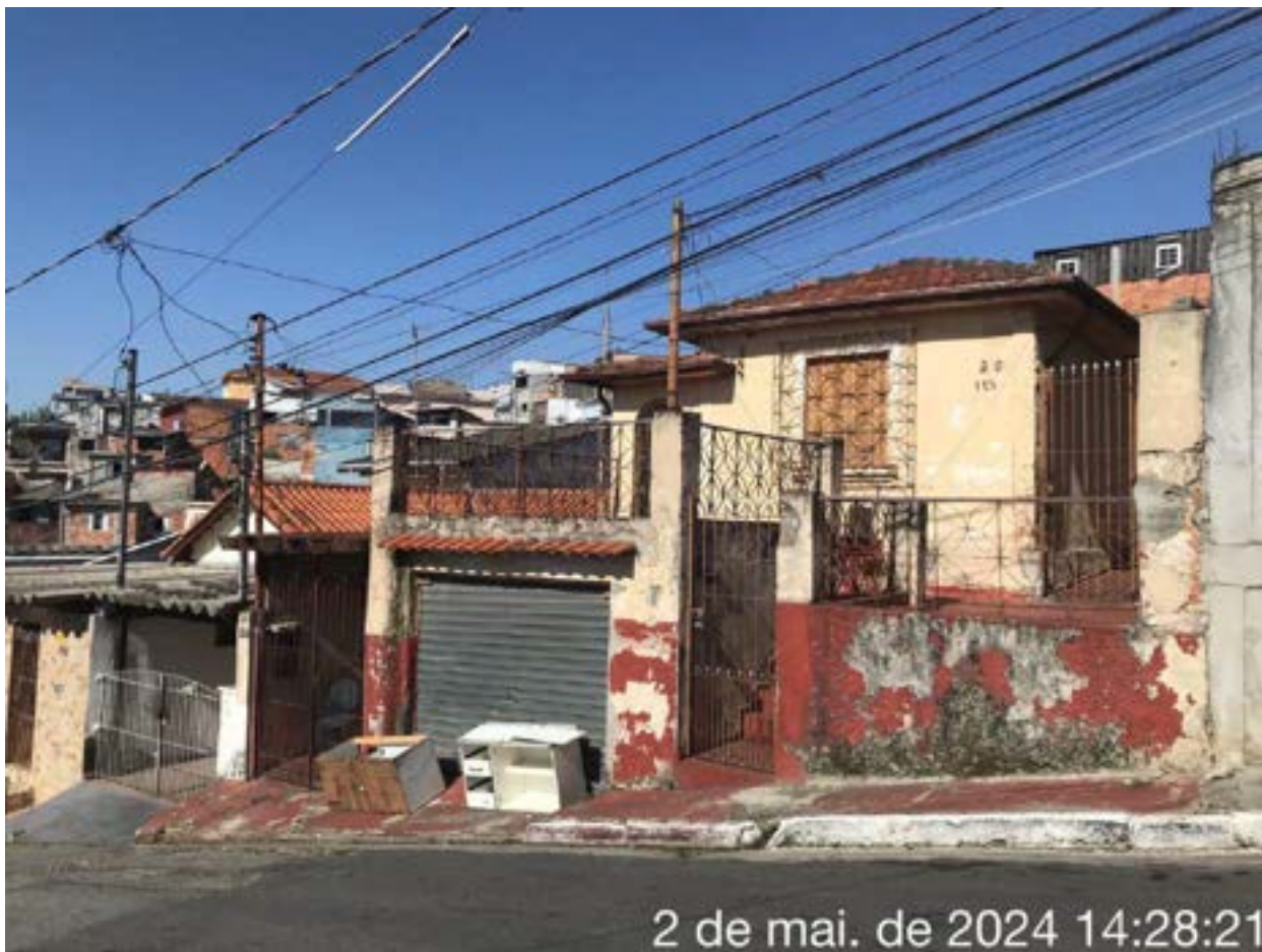
FOTO 1: FACHADA FRONTAL DO IMÓVEL, RUA AIGUARÁ, 118 e 124 (20 e 20 FUNDOS) - JARDIM DE LORENZO, SÃO PAULO - SP, 03715-030
