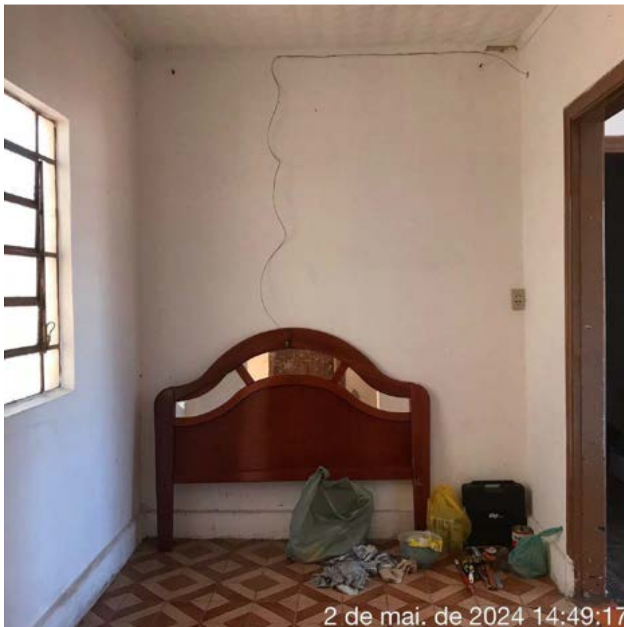
FOTO 5: DORMITÓRIO EDIFICAÇÃO DE Nº 118
