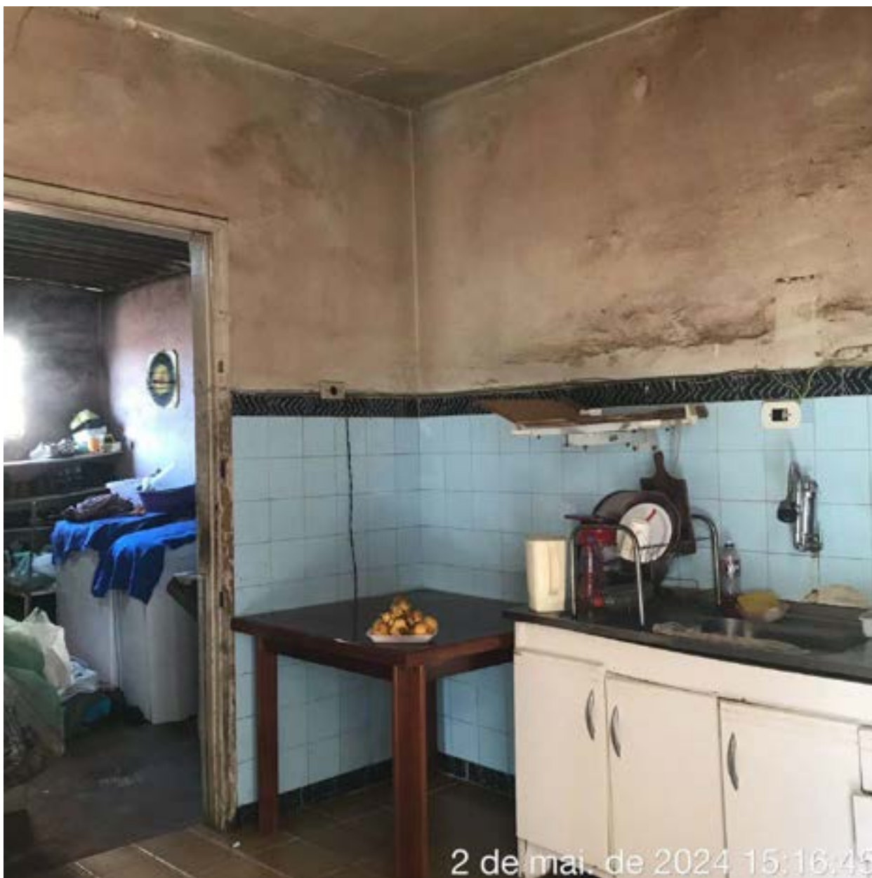
FOTO 12: COZINHA EDIFICAÇÃO DE Nº 124
