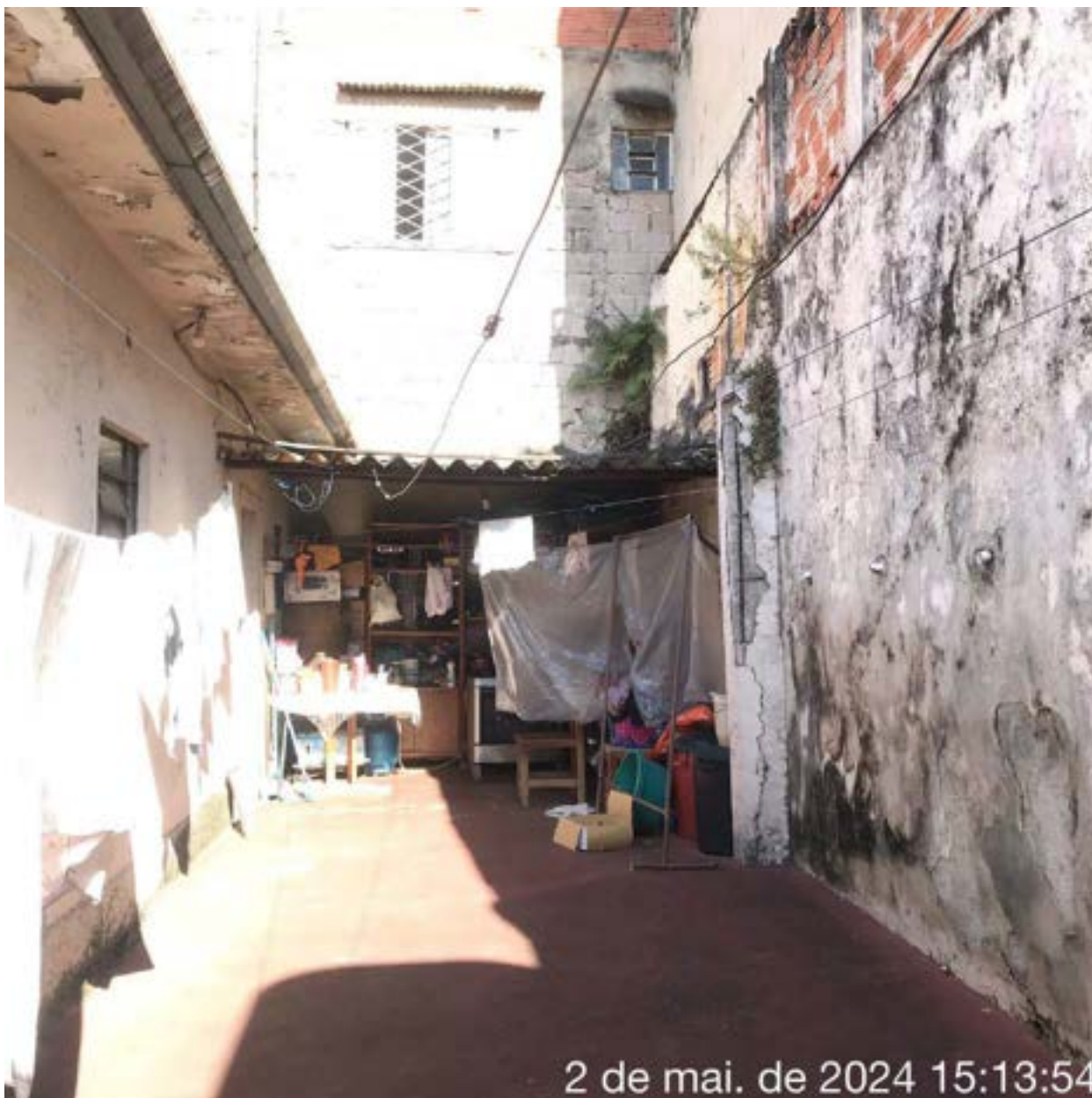
FOTO 17: FACHADA EXTERNA EDIFICAÇÃO DE Nº 124
