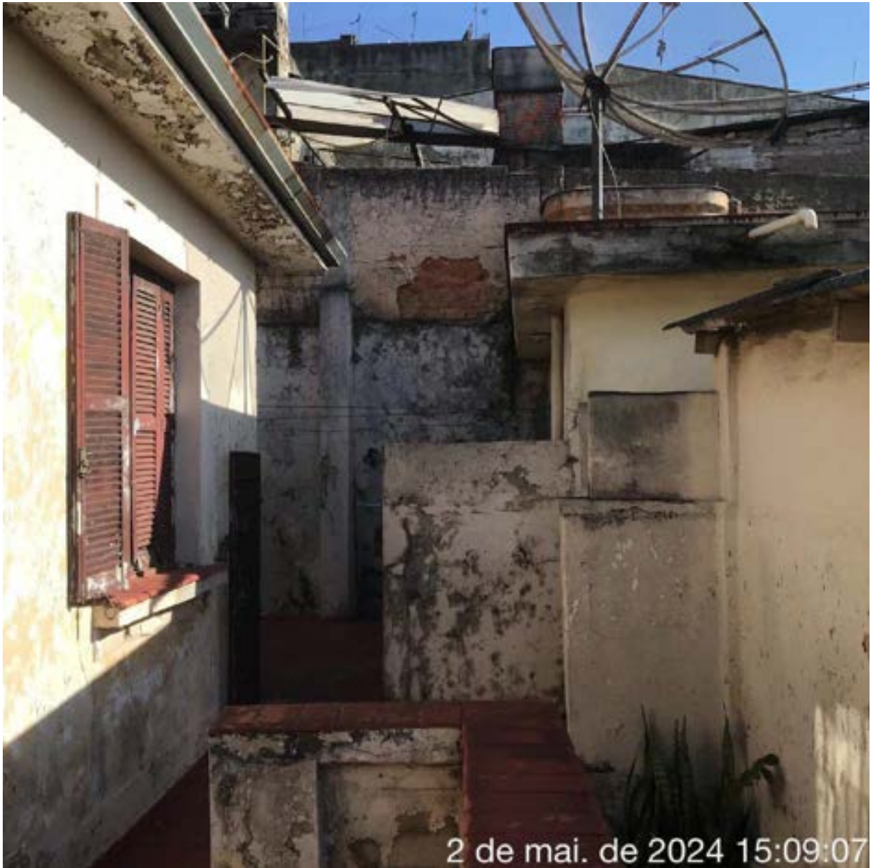
FOTO 10: FACHADA POSTERIOR EDIFICAÇÃO DE Nº 118
