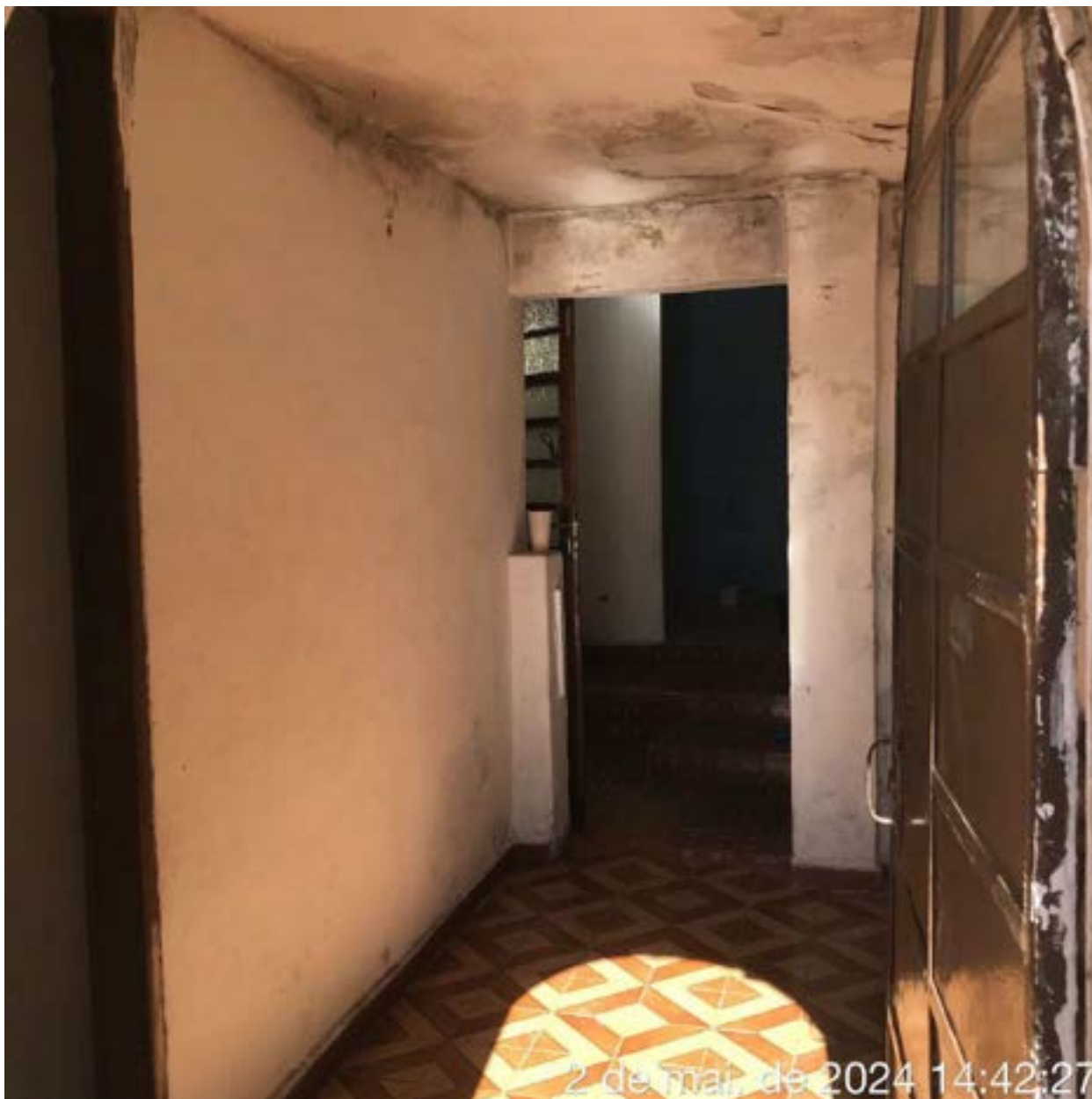
FOTO 3: ENTRADA EDIFICAÇÃO DE Nº 118
