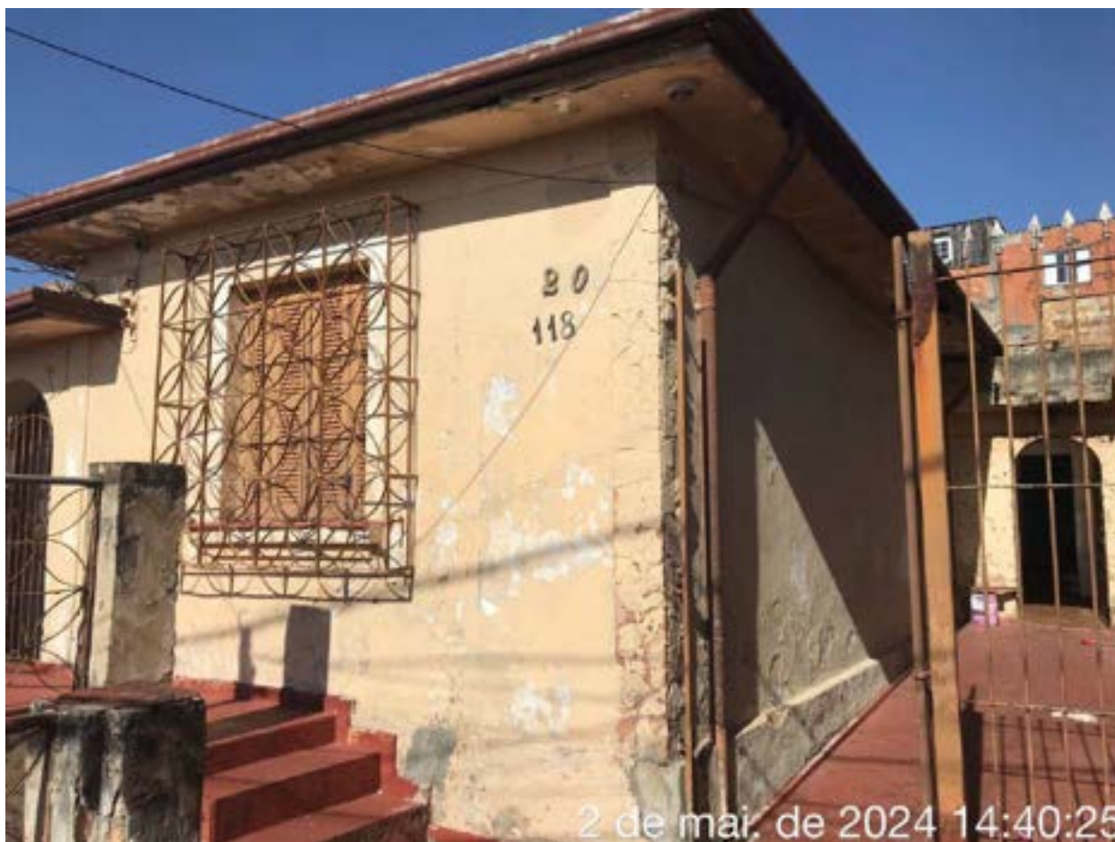
FOTO 2: FACHADA FRONTAL EDIFICAÇÃO DE Nº 118
