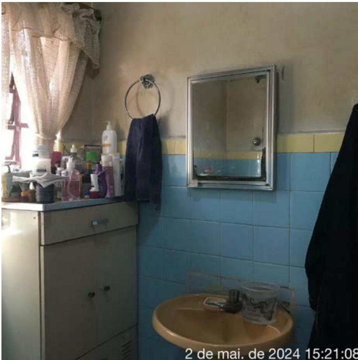
FOTO 15: BANHEIRO EDIFICAÇÃO DE Nº 124
