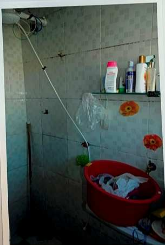
Foto de nº 18: Vista do banheiro de empregada.
