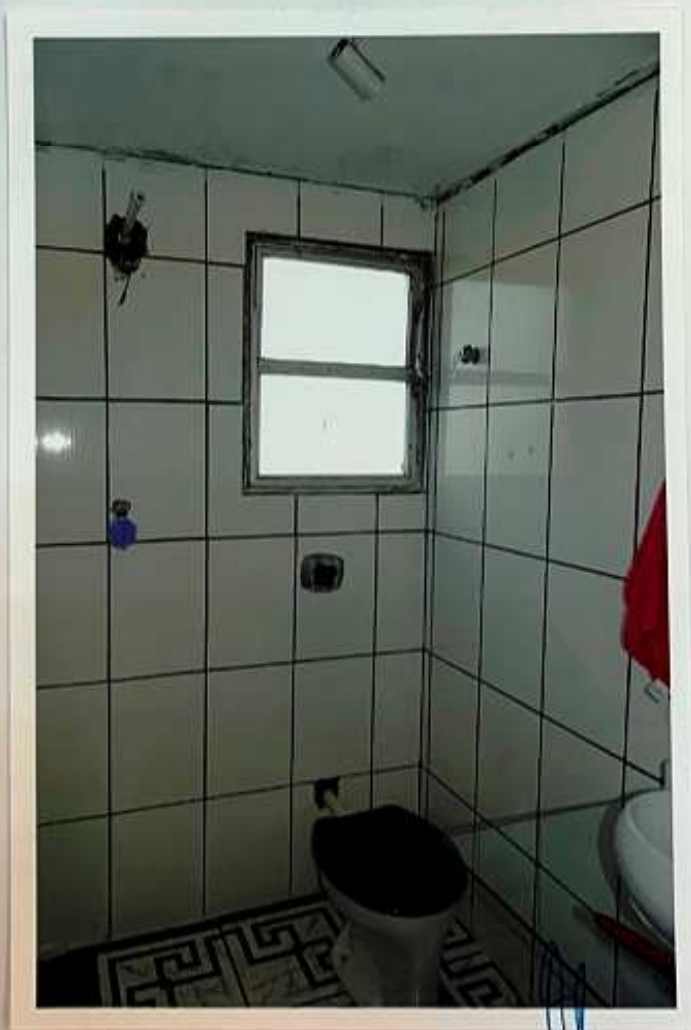
Foto de nº 15: Vista do banheiro social.
