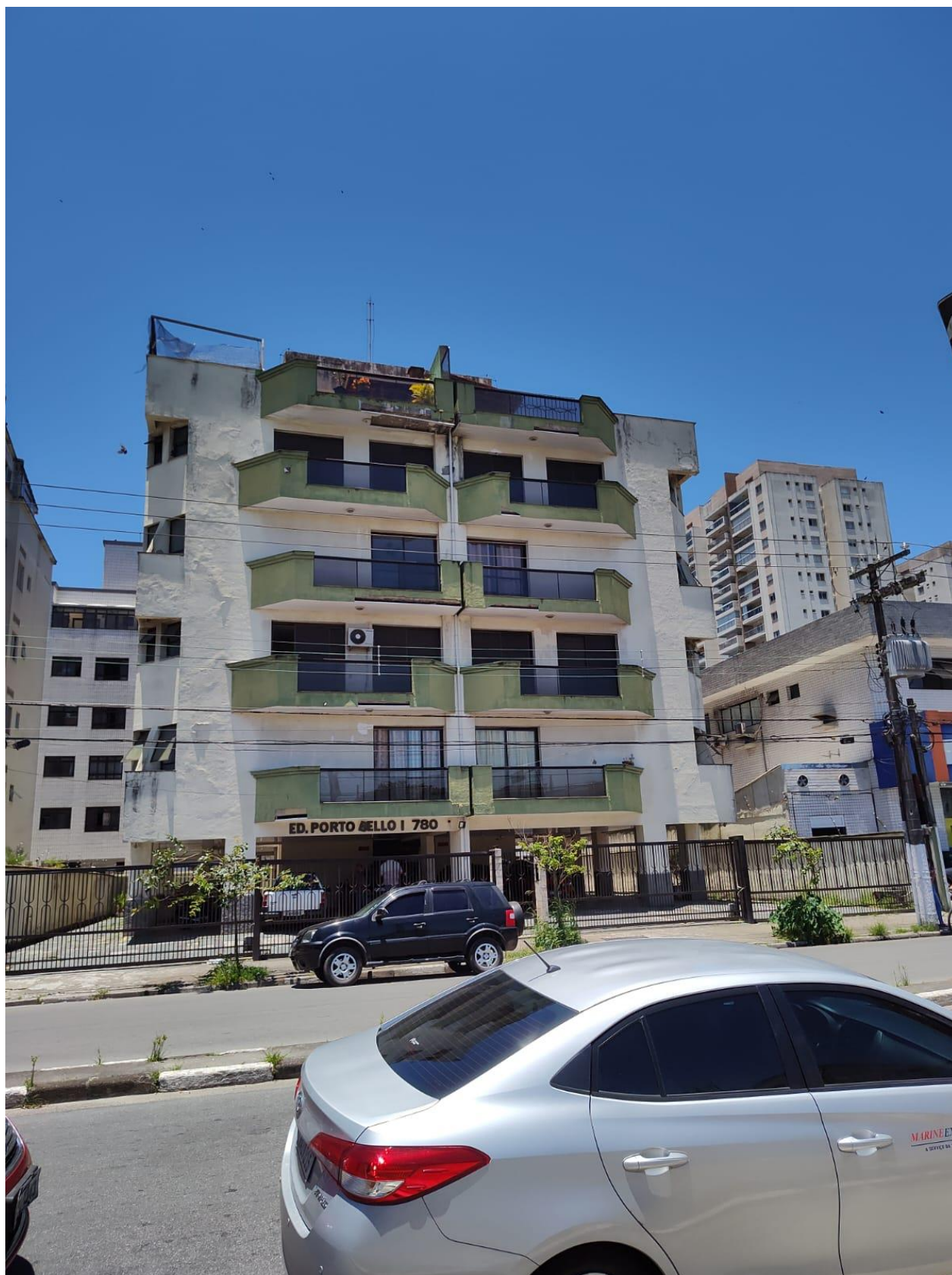
Fachada do prédio
