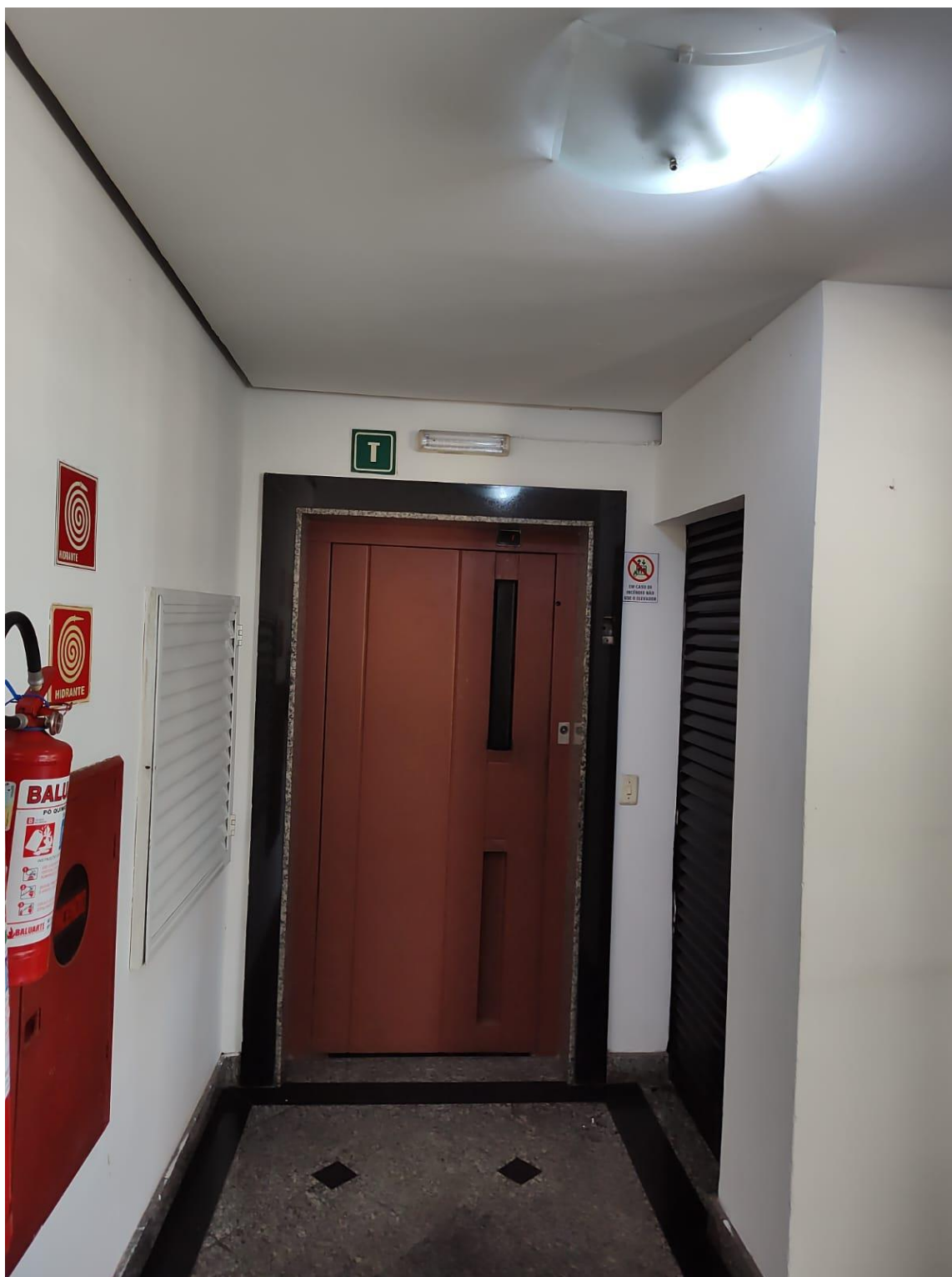
Entrada o Elevador
