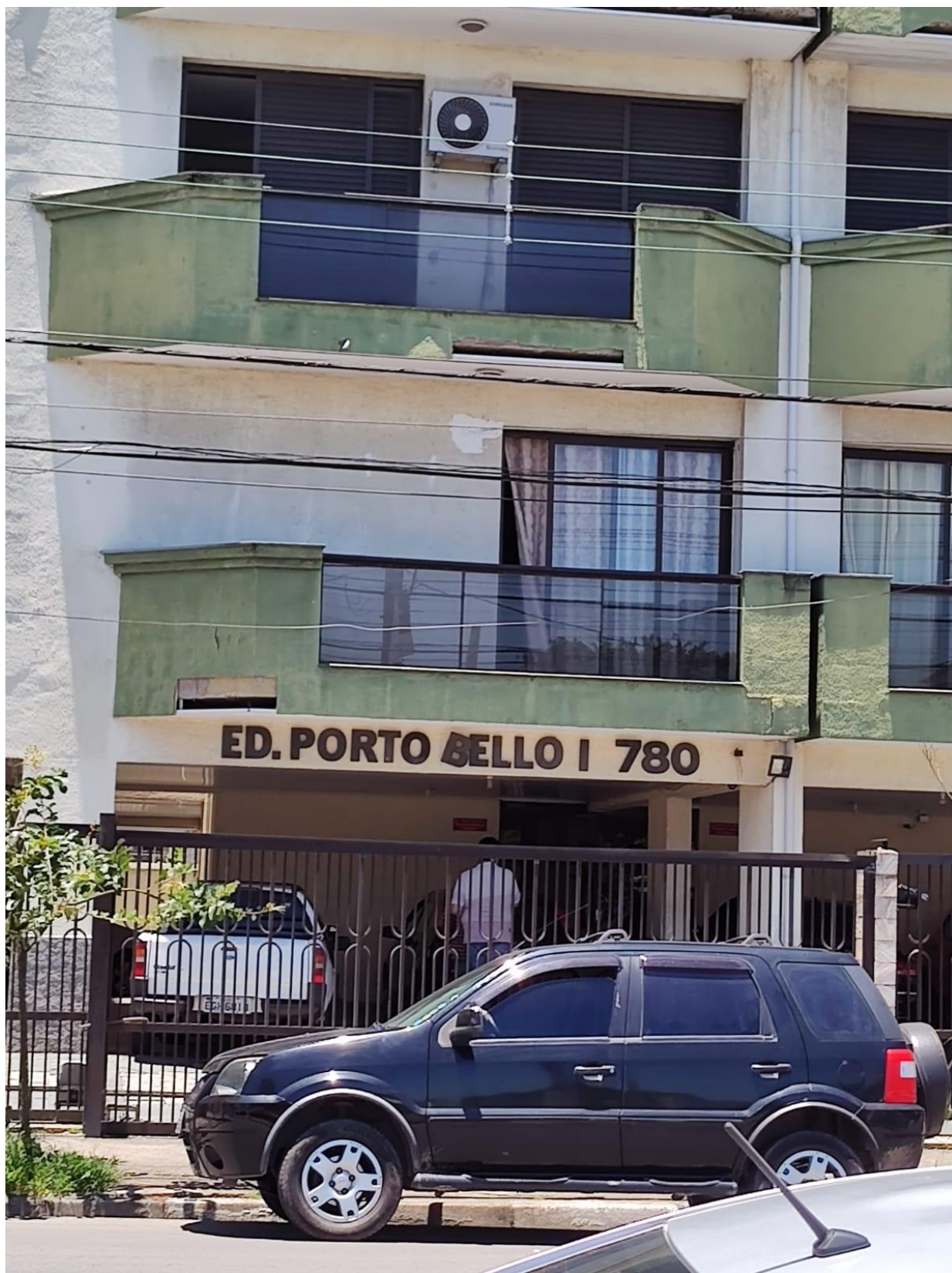
Fachada Ed Porto Bello I 780
