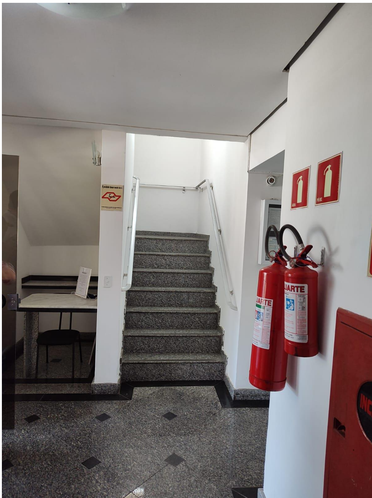
Escada de Acesso para os apartamento
