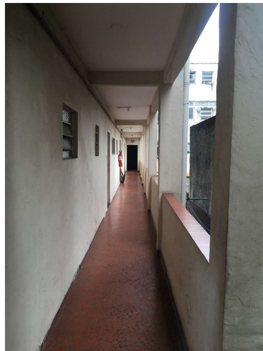
Continuação do corredor de acesso aos apartamentos do 1º andar.
