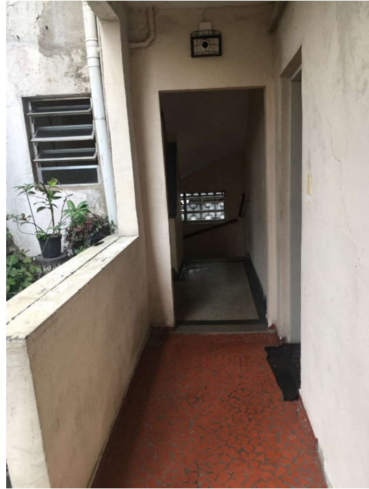
Entrada do corredor de acesso aos apartamentos do 1º andar.
