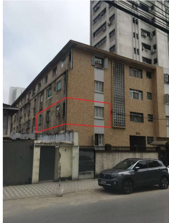
Fachada frontal do edifício com vista lateral parcial esquerda. Local do apartamento 12 marcado com cor vermelha.
