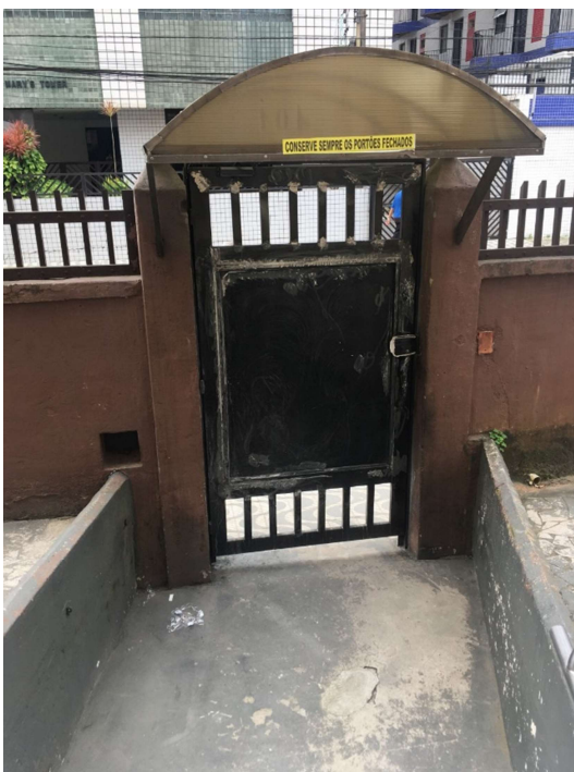
Portão de entrada do edifício.
