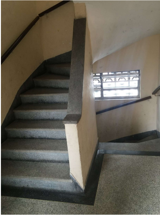
Hall de escadaria.
