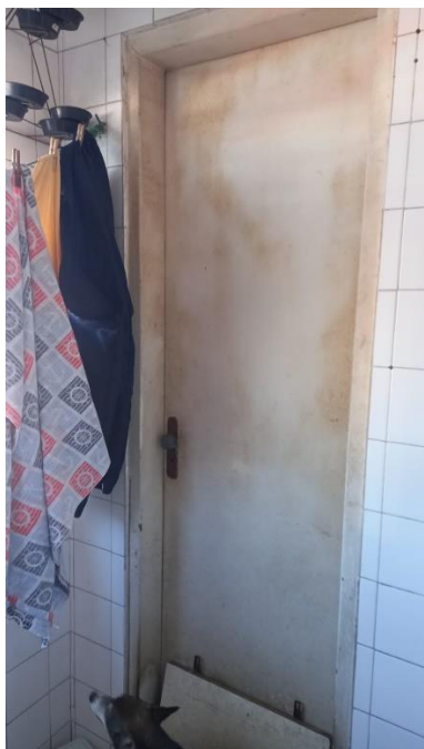
FOTO 21: Porta de acesso ao banheiro de serviço.
