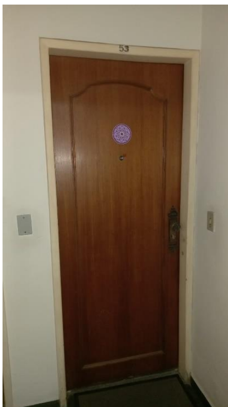
FOTO 16: Porta de entrada do apartamento 53 do Bloco Edifício Simone.
