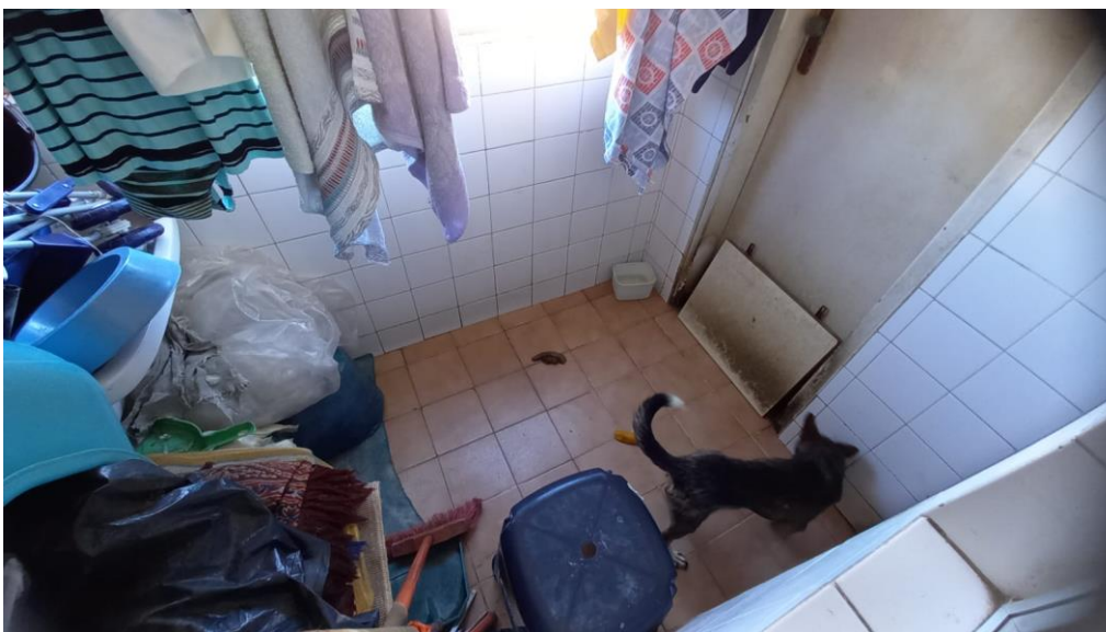
FOTO 20: Área de Serviço, o banheiro não foi possível fotografar, está desativado, é usado como depósito de caixas.
