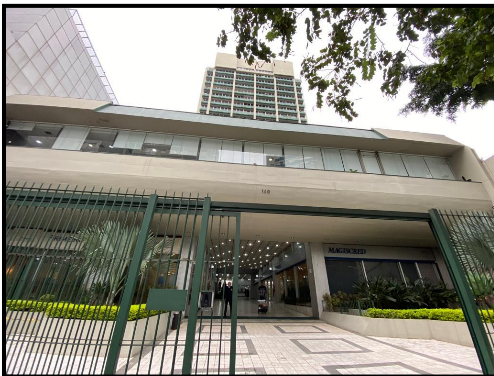
Imagem 1 – Fachada do Edifício
