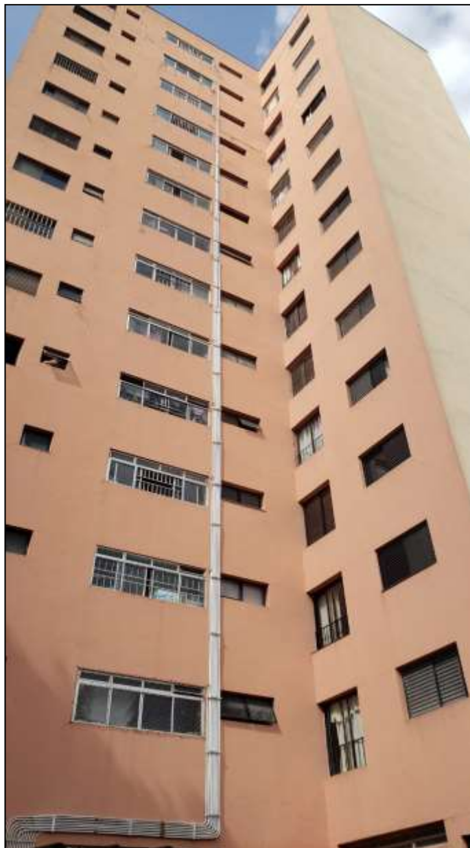
Foto 03 – Vista da fachada dos fundos.
