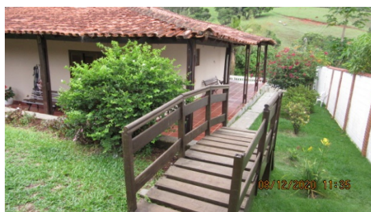
Foto 35 – Vista da edificação principal
