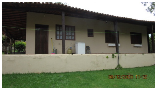
Foto 30 – Vista da edificação principal
