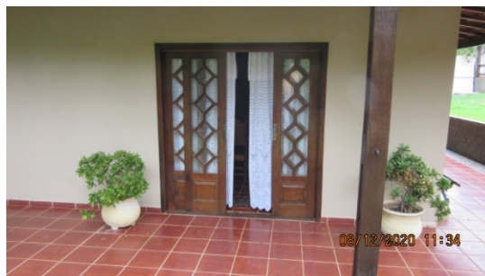
Foto 32 – Vista da edificação principal
