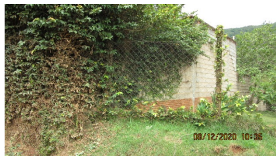
Foto 06 – Lateral direita do imóvel avaliando
