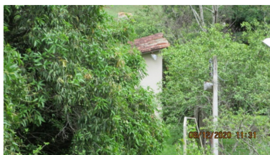
Foto 28 – Vista parcial da Edícula
