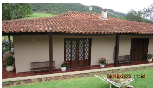
Foto 34 – Vista da edificação principal
