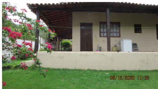
Foto 29 – Vista da edificação principal
