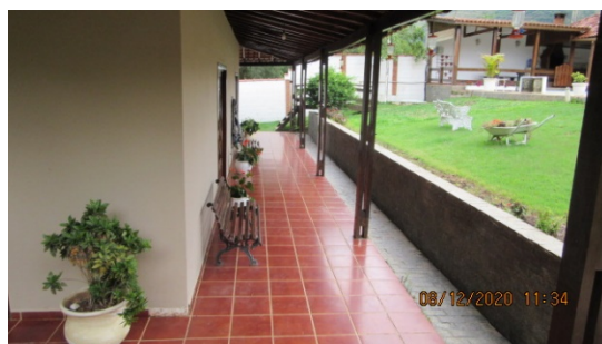
Foto 33 – Vista da edificação principal
