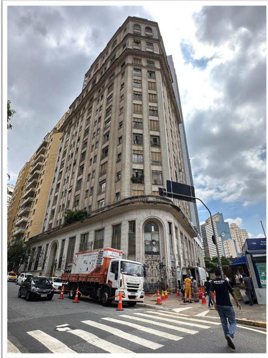
Figura 3 - Vista frontal do Edifício
