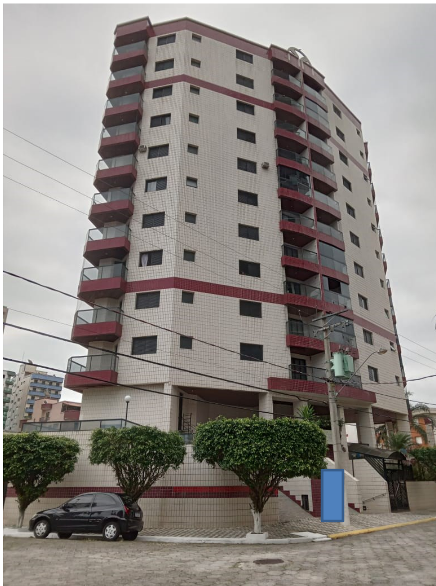
FOTO 02:- Vista da fachada do imóvel.
