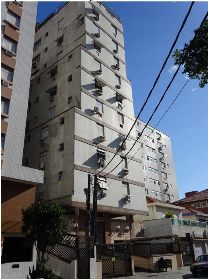
FOTO 1: Vista da fachada frontal e lateral esquerda do edifício Itacolomy.
