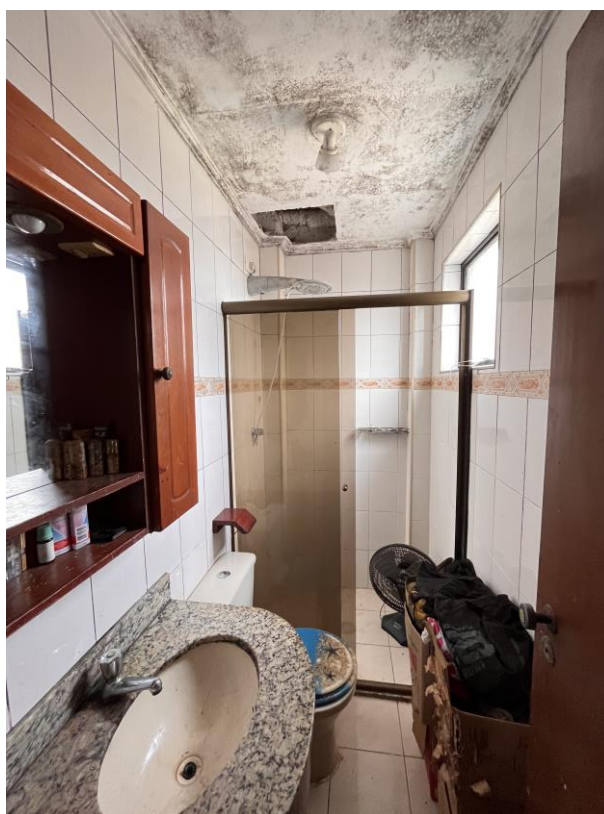
Figura 13: Banheiro da suíte.
