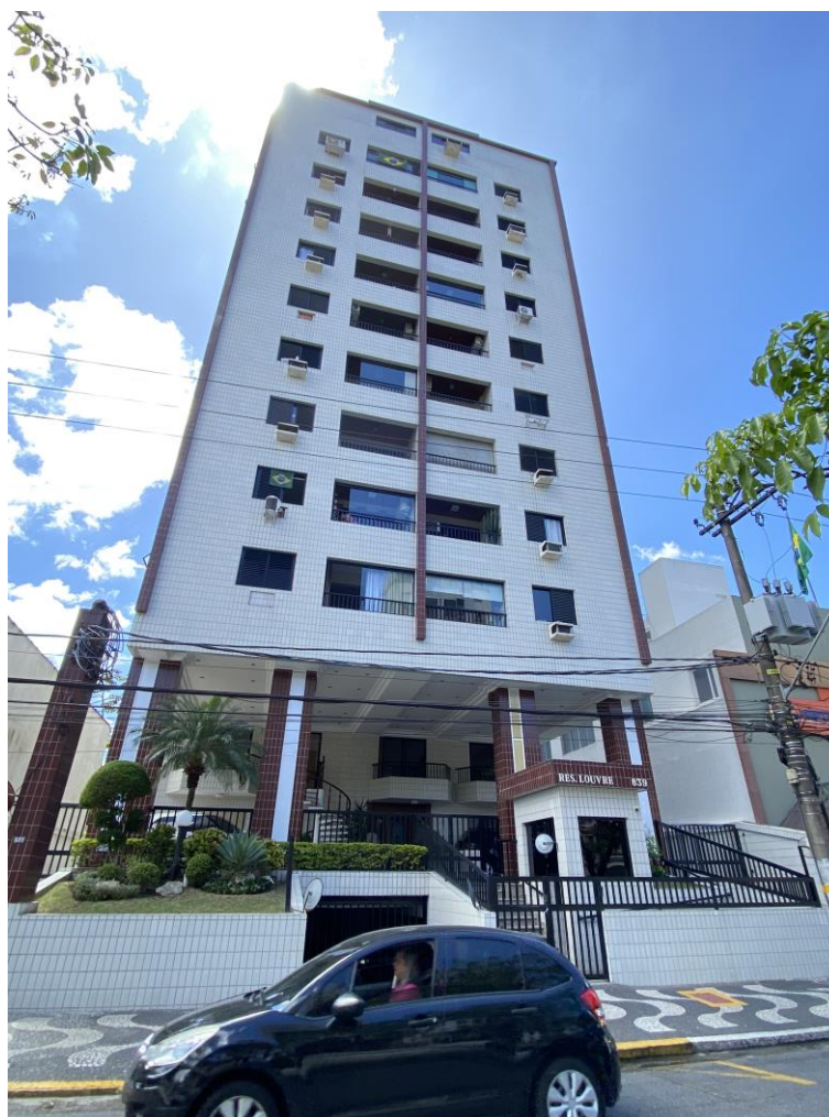
Figura 2: Vista geral do imóvel.
