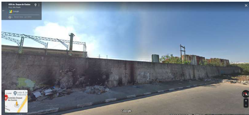
Imagem 2: vista lateral, ao final da Av. Duque de Caxias. Fonte: maps.google.com
