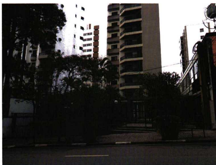
FOTOS 3/4 - Vista frontal na entrada do condomínio , local do imóvel avaliando e fachada do prédio.
