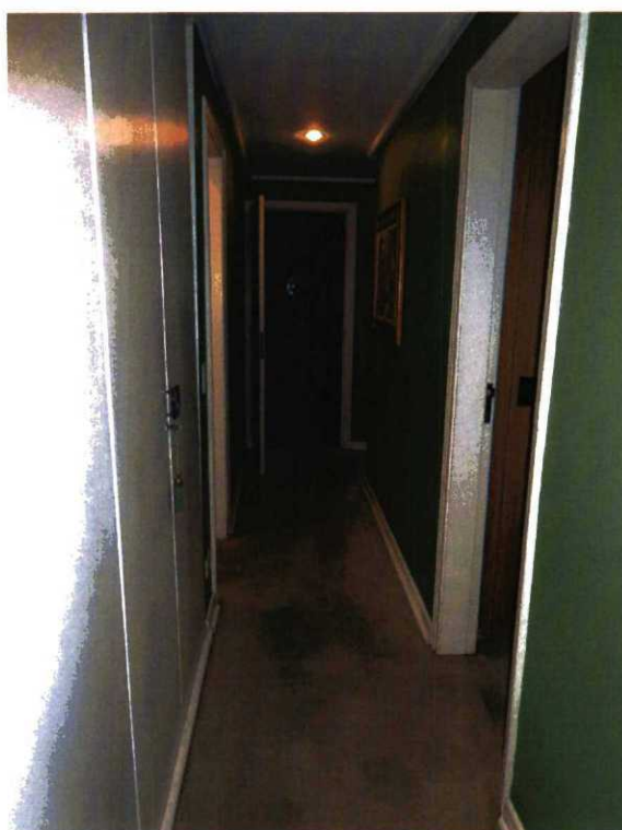
FOTOS 17/18 : Detalhe em área de circulação do imóvel.
