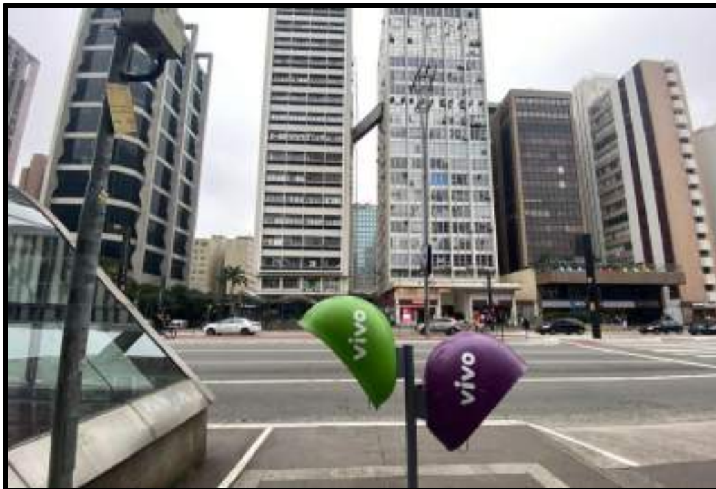
Imagem 2- Vista da rua do Edifício
