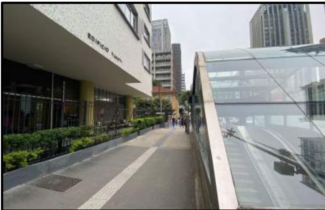
Imagem 4- Vista da rua lado direito do Edifício
