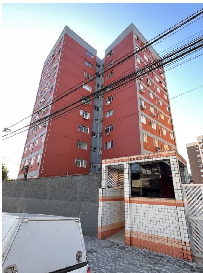
Figura 2: Vista geral do Edifício Perequê.
