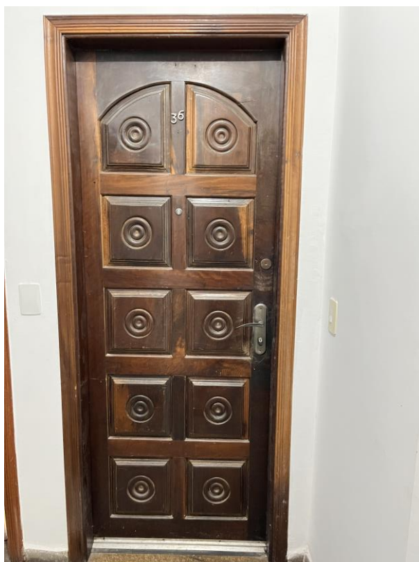
Figura 6: Porta da unidade 36, bloco 1.
