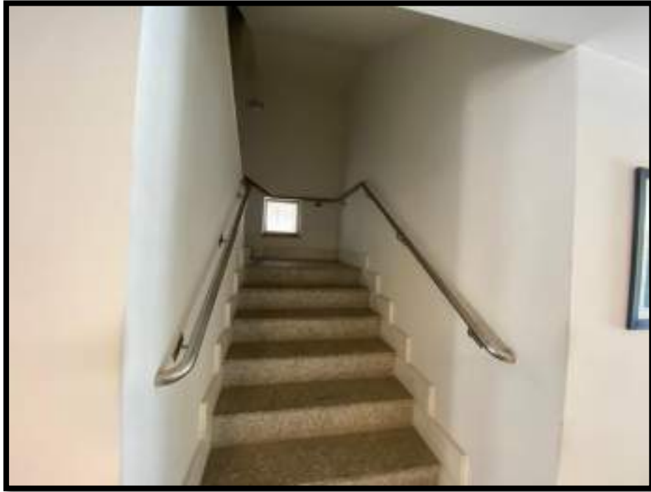
Imagem 8- Escada de emergência
