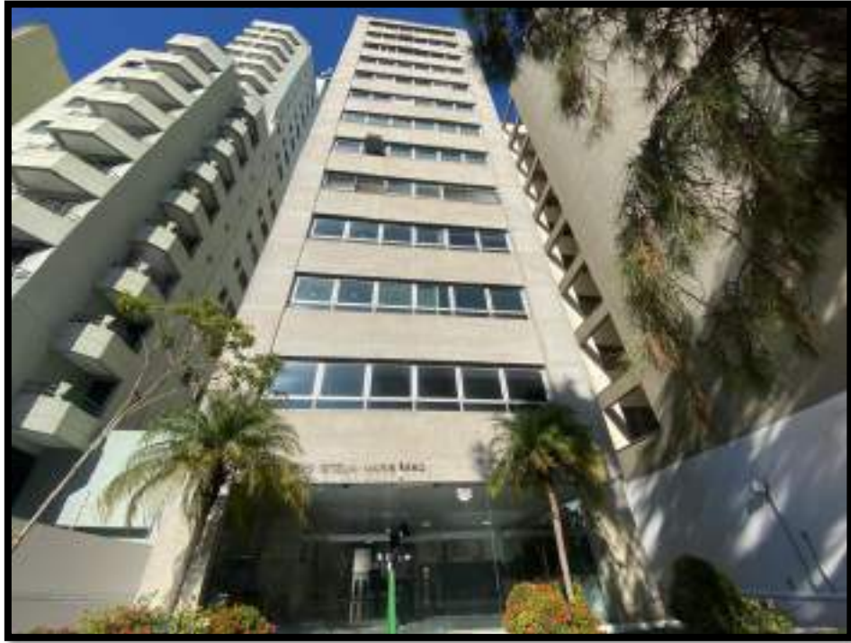
Imagem 2- Fachada do Edifício
