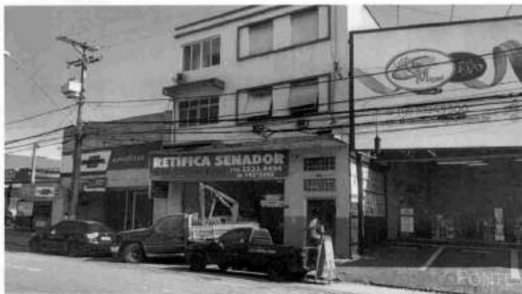
Acima, temos uma tomada da testada do Edifício em questão.
