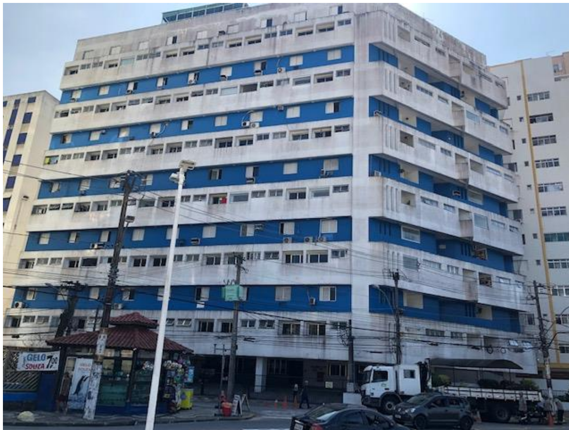
FOTO 2 – VISTA DA EDIFICAÇÃO
