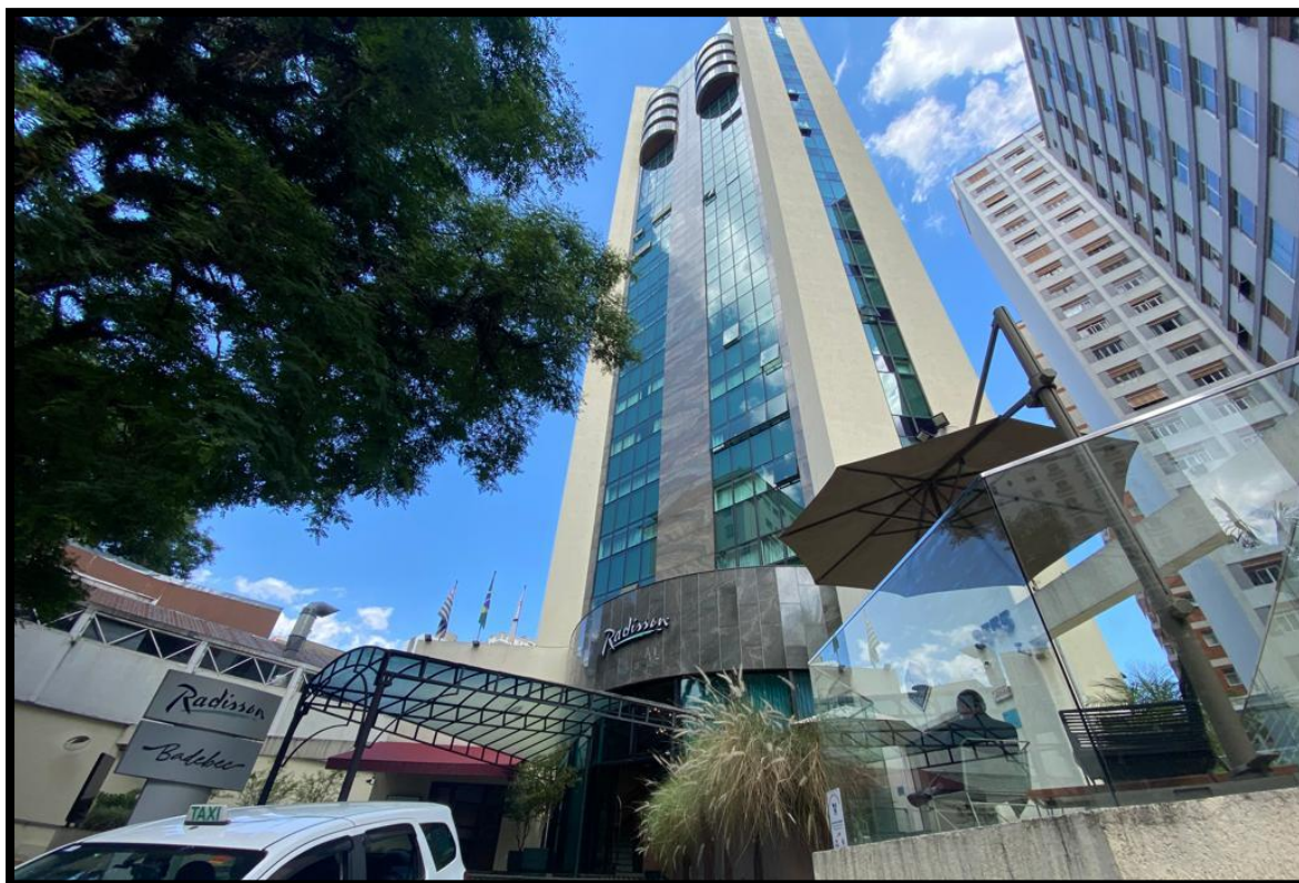
Imagem 1 – Fachada do Condomínio Edifício The Imperial Hall
