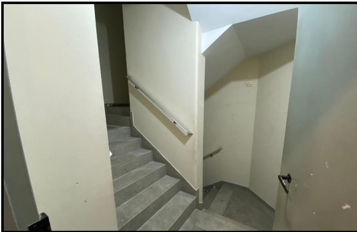
Imagem 21 – Escadas de emergência
