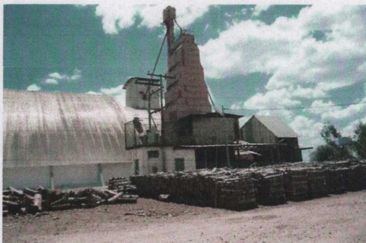
MOEGA E CASA DE MÁQUINAS.
