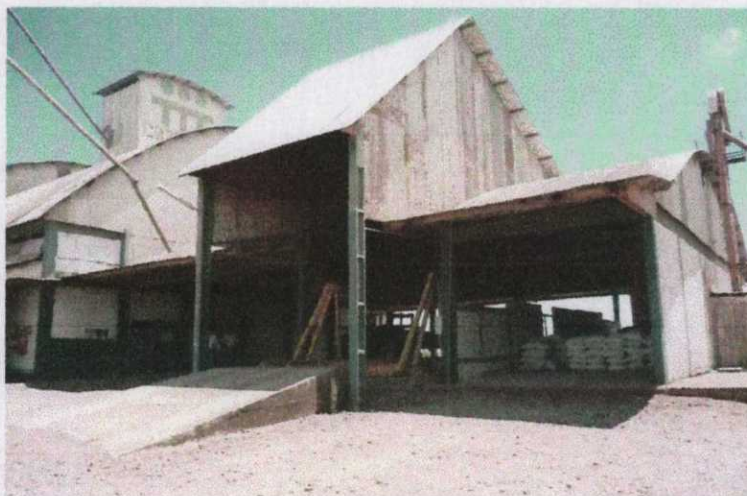
MOEGA E CASA DE MÁQUINAS.
