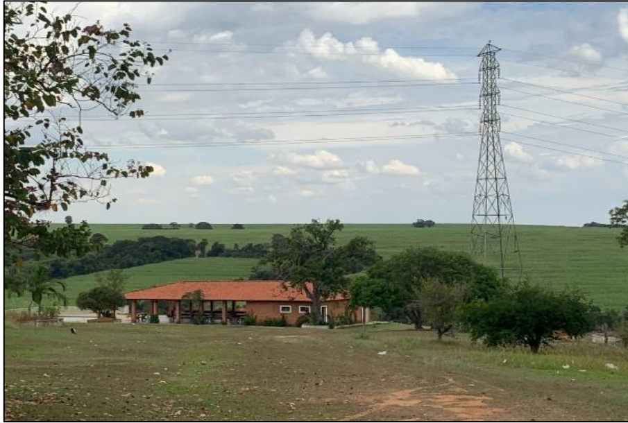
Figura 7 - Torre de transmissão no imóvel
