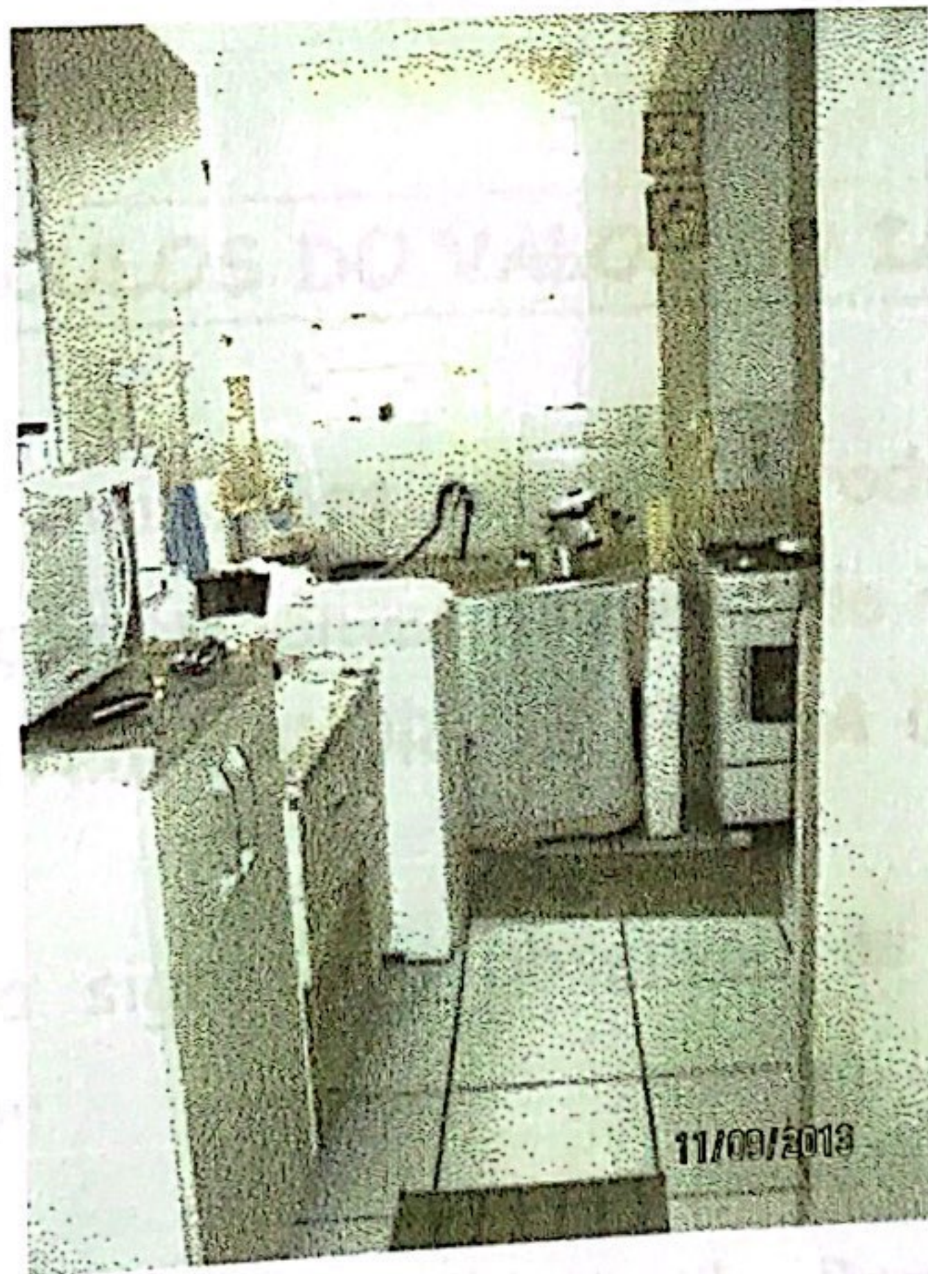
FOTO N° 04 : Visualização da cozinha integrada a área de serviço, enfocando o piso em revestimento cerâmico, paredes revestidas com meia barra de azulejos e pintura látex sobre massa fina, além de janela de alumínio.
