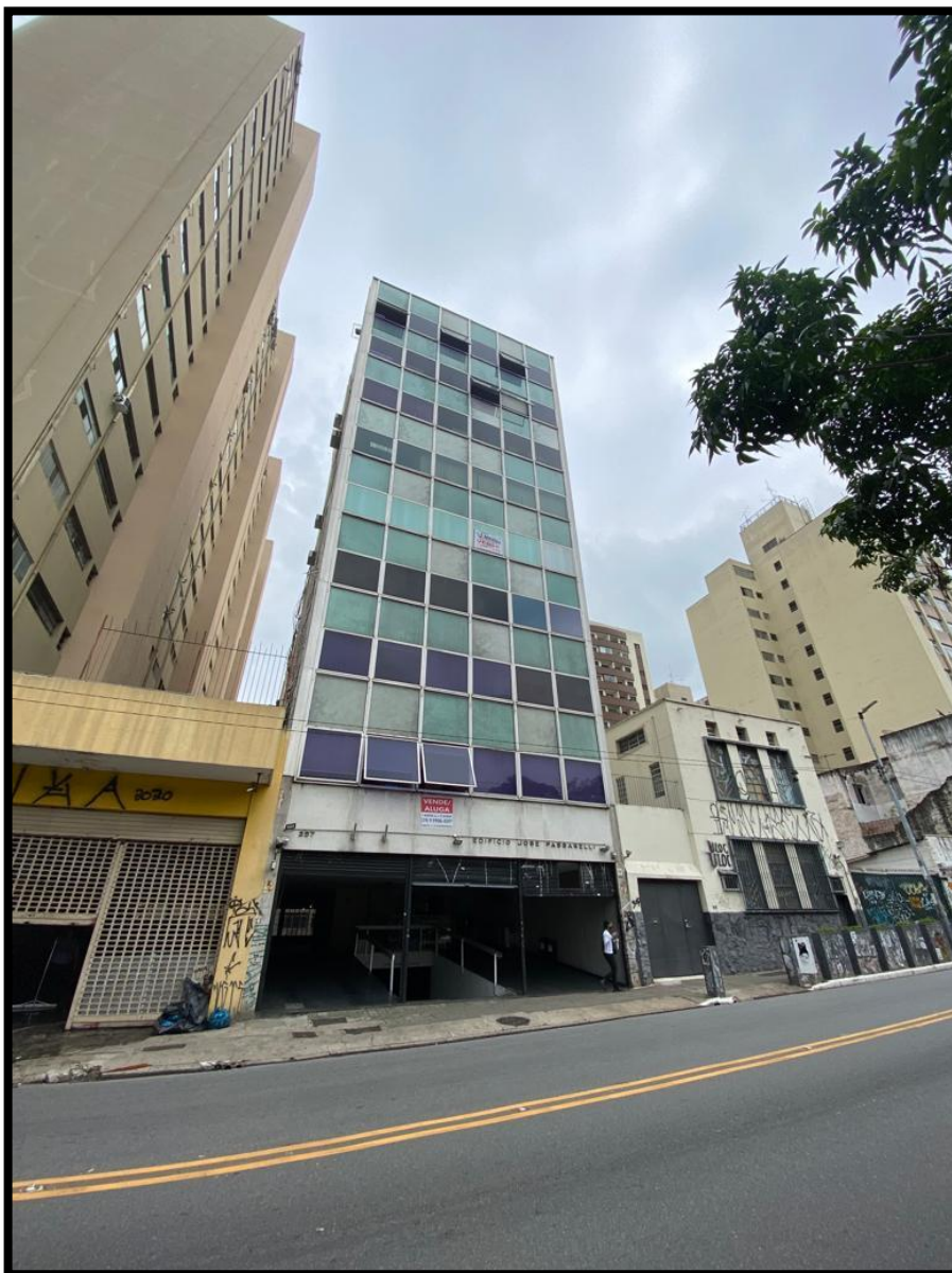
Imagem 2- Vista da rua da entrada do Edifício
