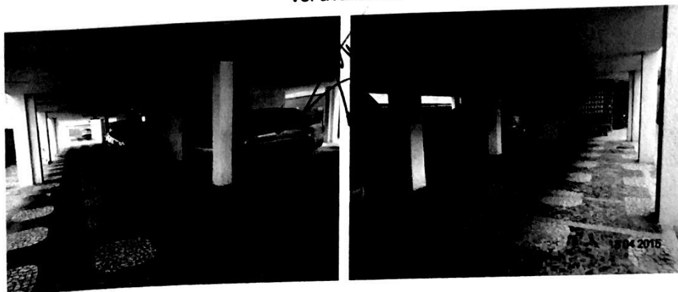
Vistas da garagem.
