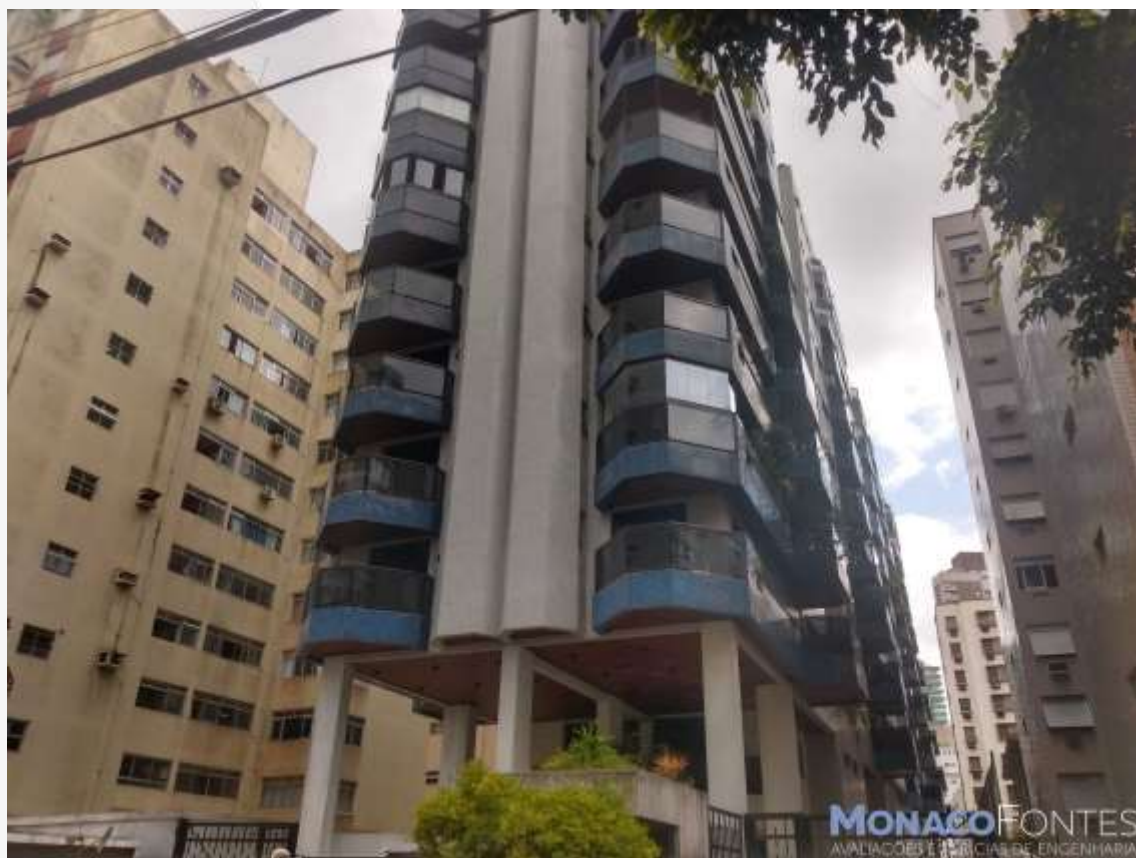
Acima, temos uma tomada da testada do Condomínio Edifícios Maria Sylvia e Maria Virgínia.
