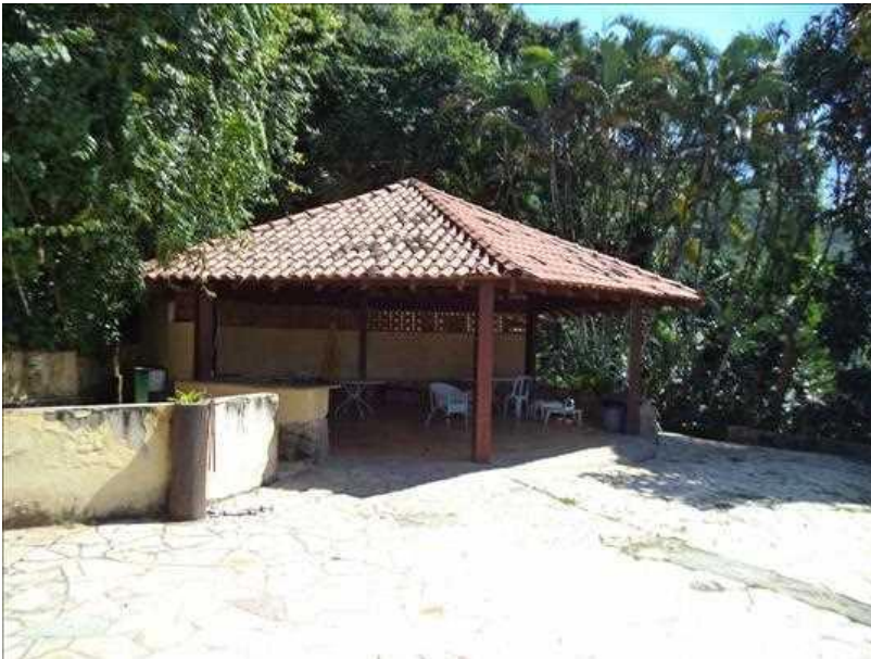
Vista geral do condomínio
