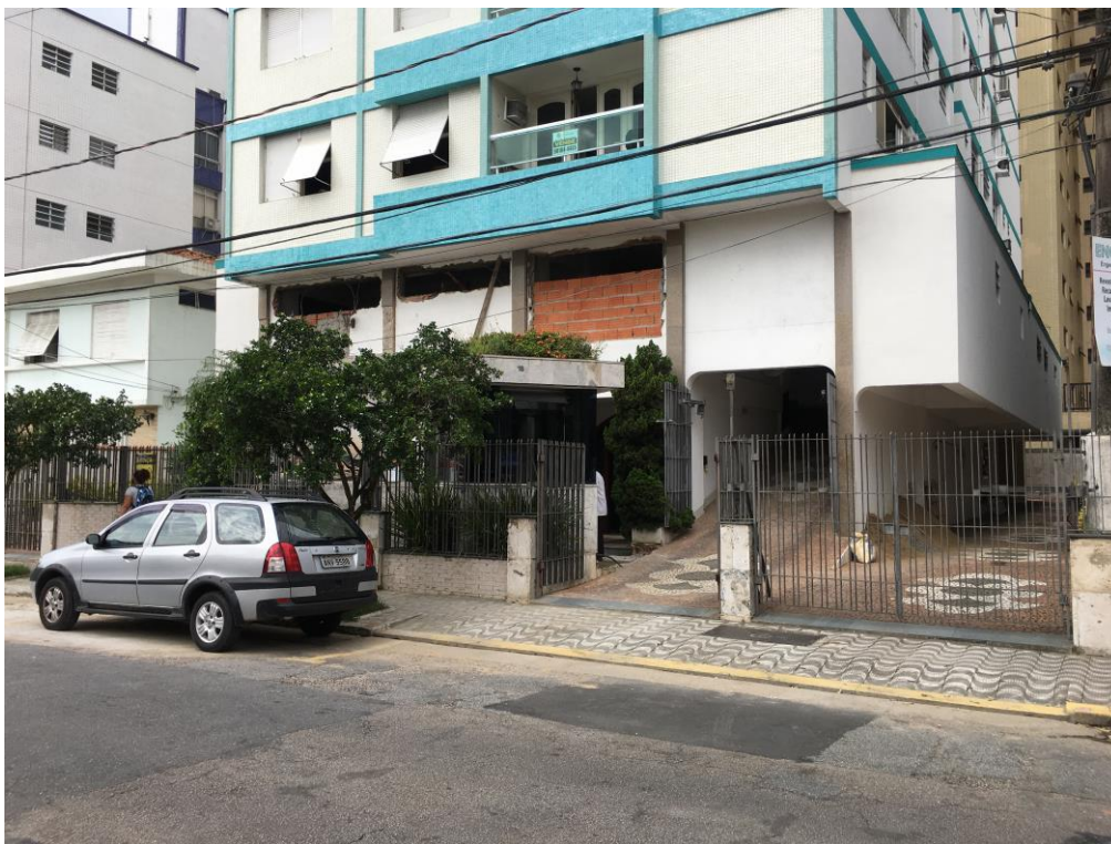
Figura 2: Vista dos acessos do Edifício San Conrado.
