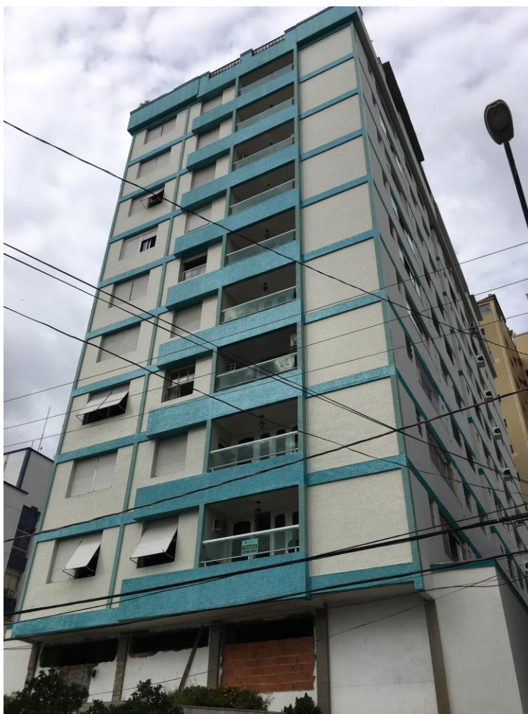
Figura 3: Vista geral do prédio.
