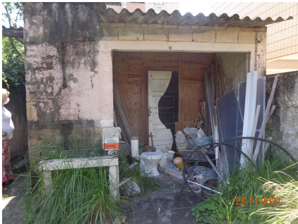
FOTO 04: Vista dos fundos da antiga garagem cuja frente encontra-se no alinhamento frontal.
