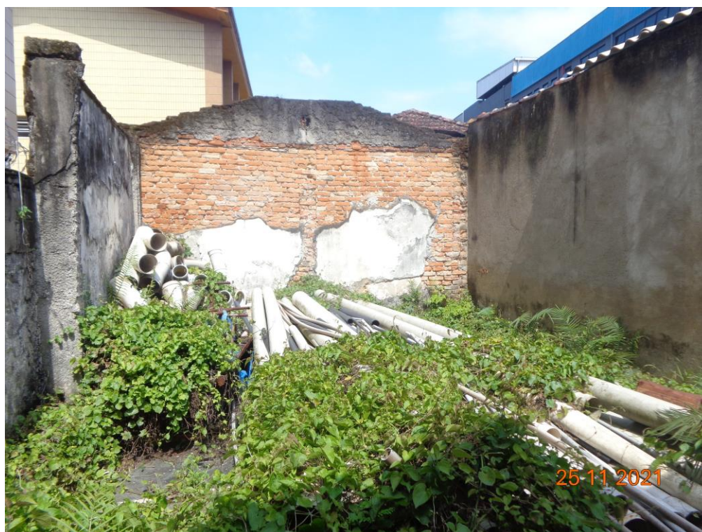
FOTO 15: Vista do trecho dos fundos do terreno do imóvel avaliando.
