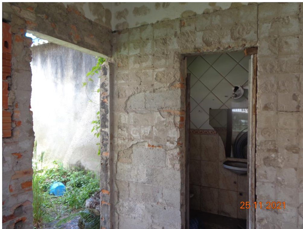
FOTO 14: Outra vista do cômodo no interior da edificação com a retirada do revestimento de azulejos das paredes, portas e batentes.
