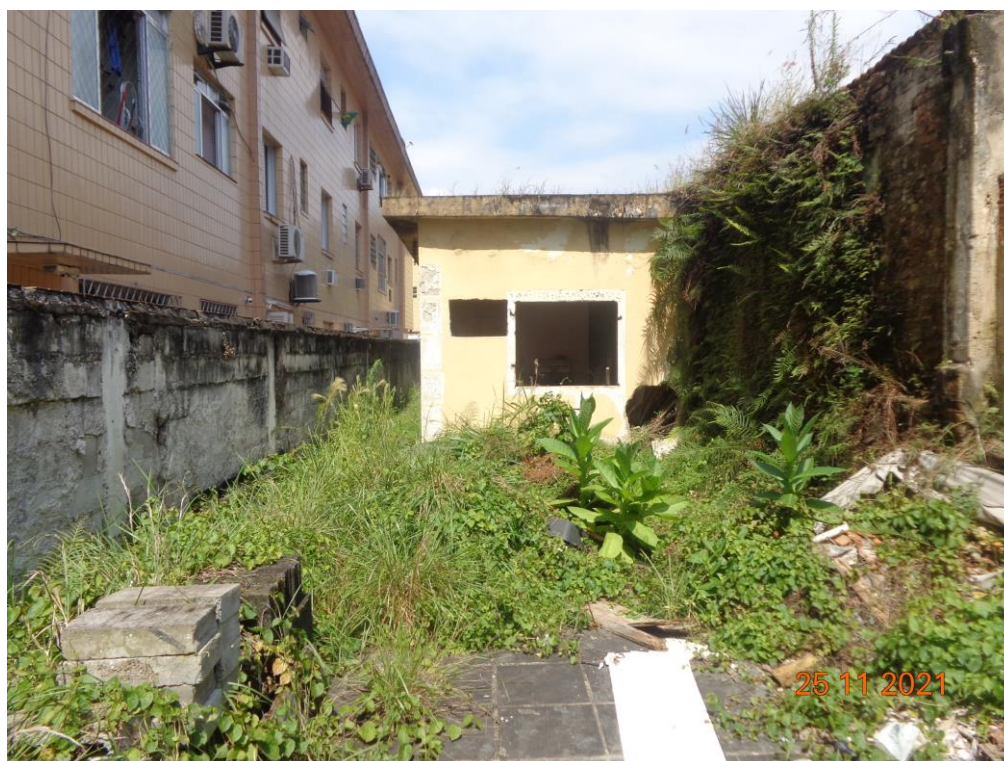
FOTO 07: Outra vista da fachada da edificação, observando-se em primeiro plano a presença de vegetação / mato.
