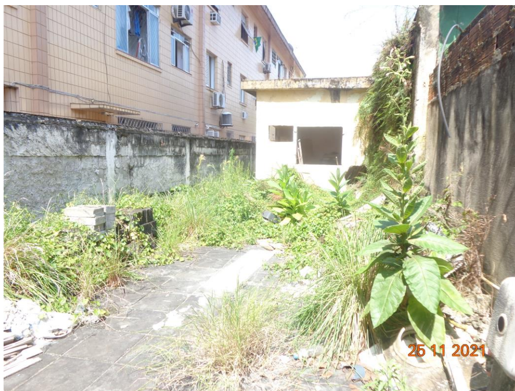
FOTO 06: Vista da área entre a garagem e a edificação principal.
