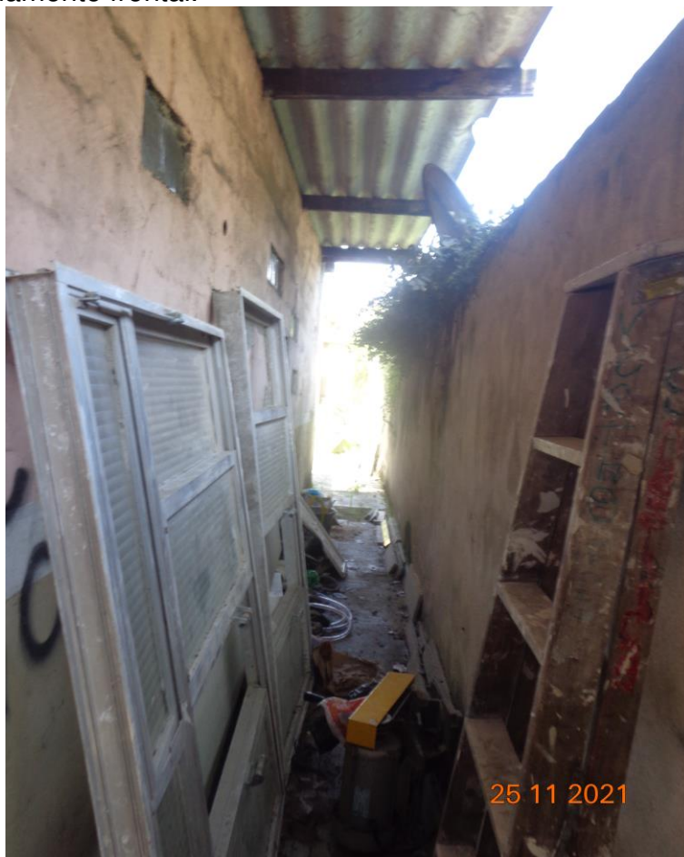
FOTO 05: Vista da passagem entre a parede da garagem e o muro divisório lateral direito.
