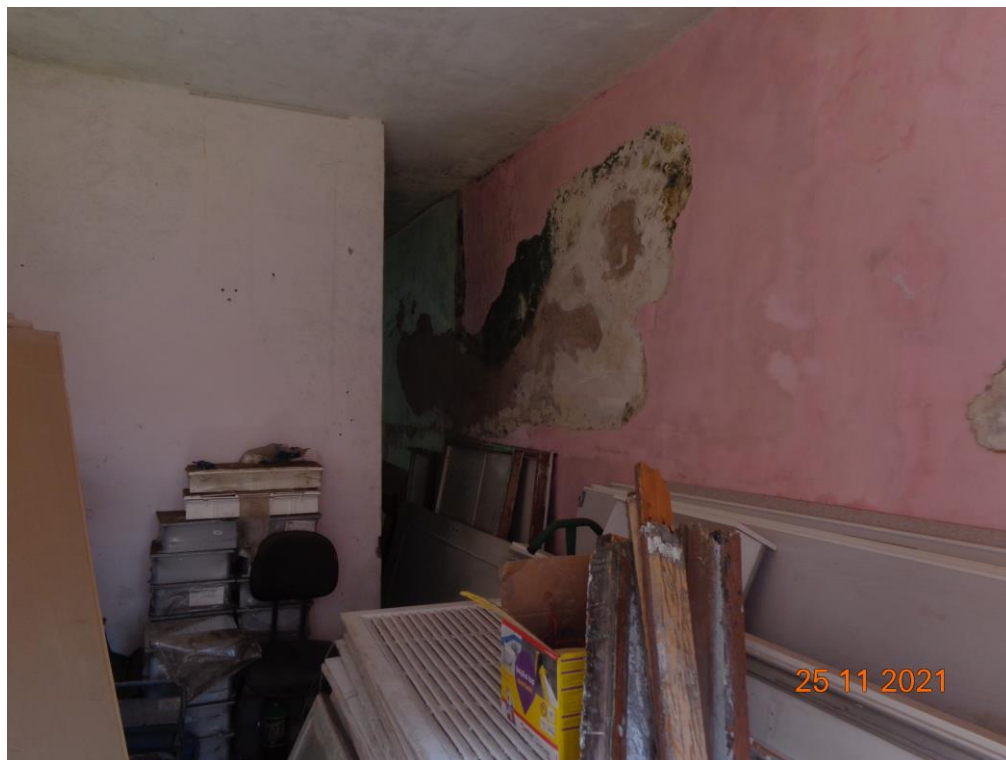
FOTO 10: Vista parcial de um dos cômodos da edificação.
