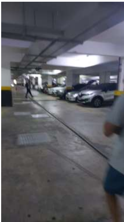
Vista getal da garagem.
