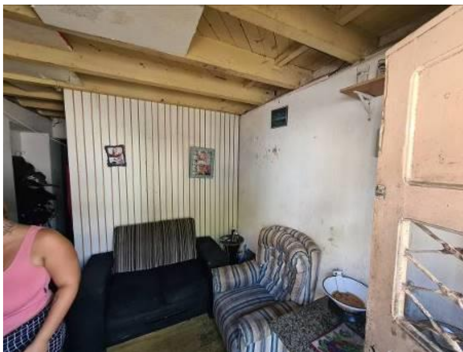
Foto 05 – Vista da sala.
