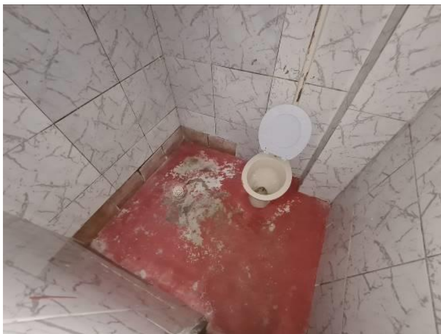
Foto 29 – Vista do banheiro da oitava moradia.
