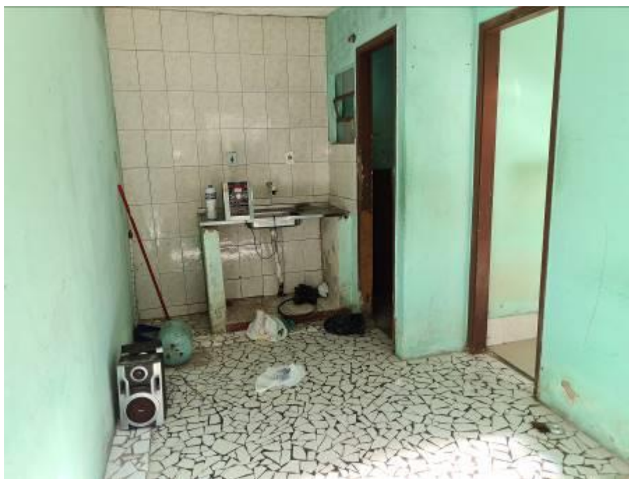
Foto 25 – Vista da cozinha da sétima moradia.
