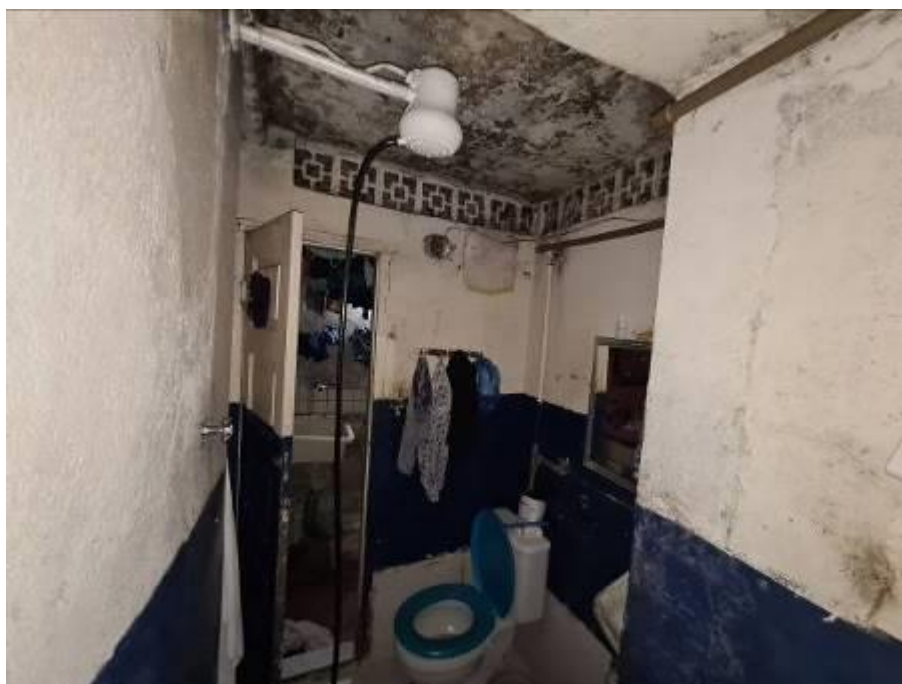
Foto 11 – Vista do banheiro.
