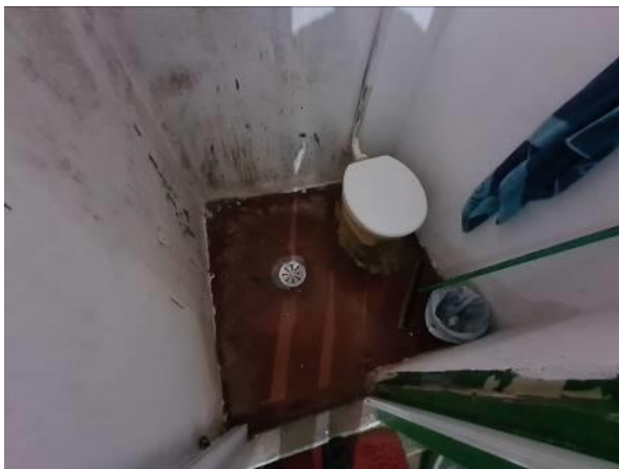
Foto 21 – Vista do banheiro da sexta moradia.
