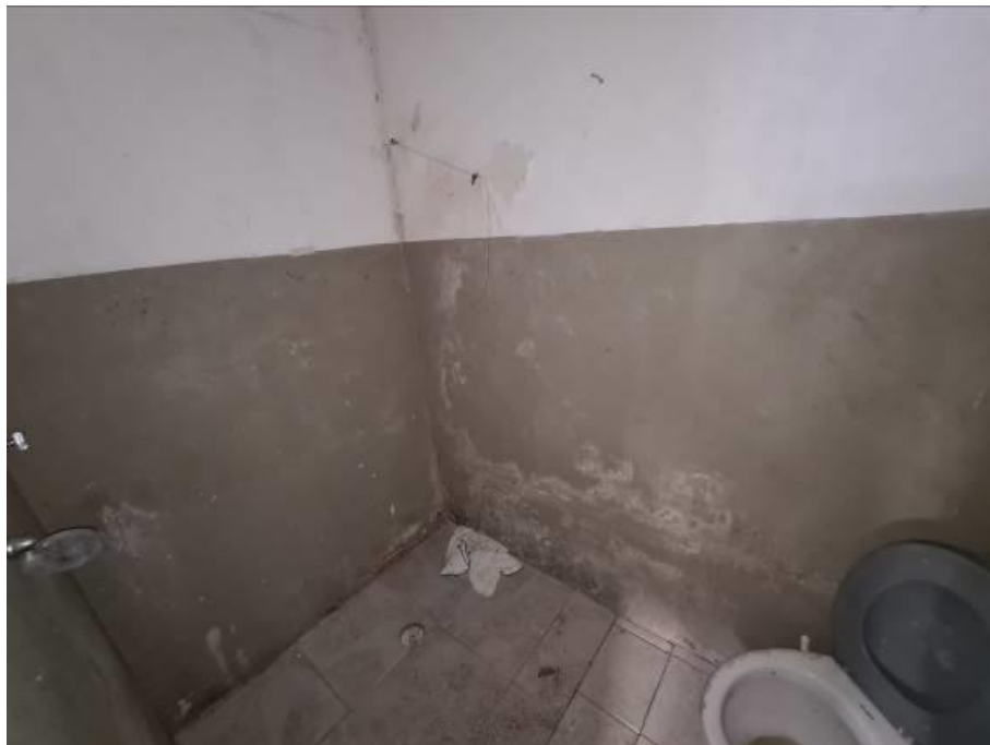
Foto 32 – Vista do banheiro da nona moradia.
