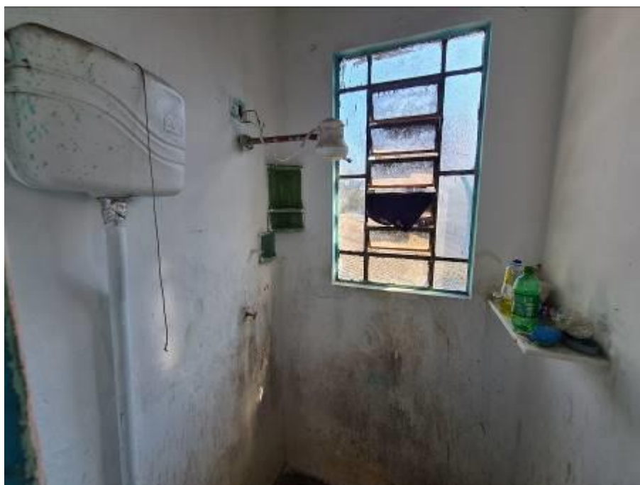
Foto 18 – Vista do banheiro da quinta moradia.
