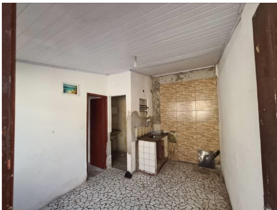
Foto 30 – Vista da cozinha da nona moradia, localizada nos fundos do terreno.
