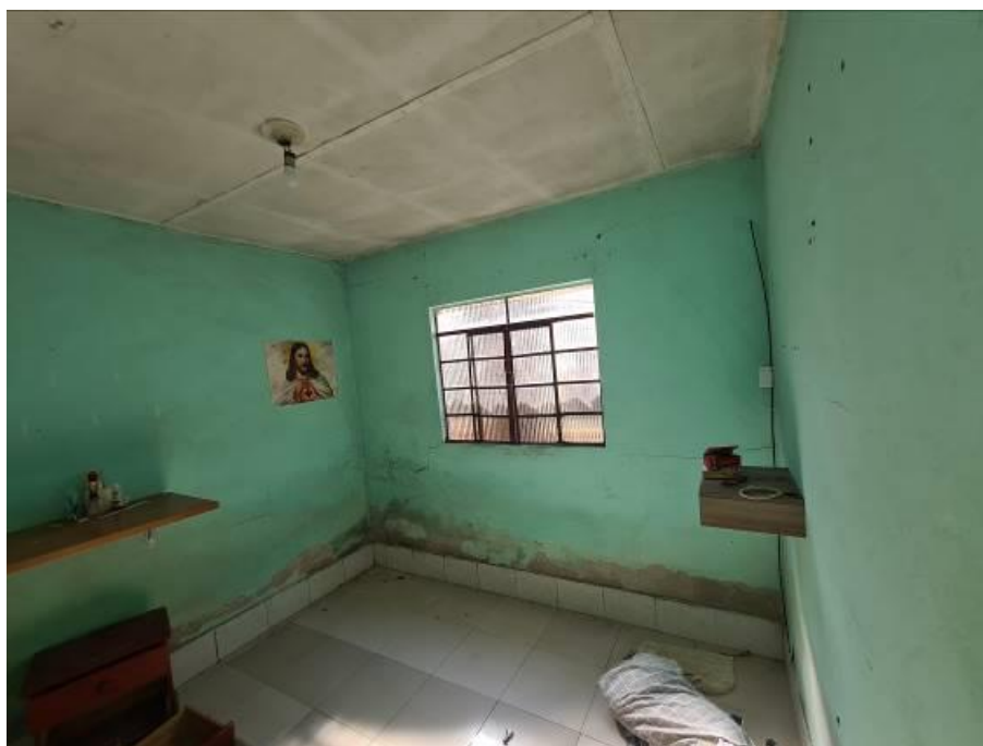
Foto 24 – Vista do dormitório da sétima moradia, localizada nos fundos do terreno.
