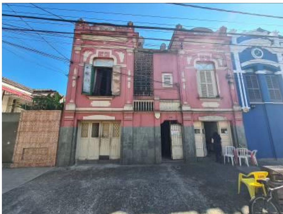
Foto 03 – Vista da fachada do imóvel avaliando.
