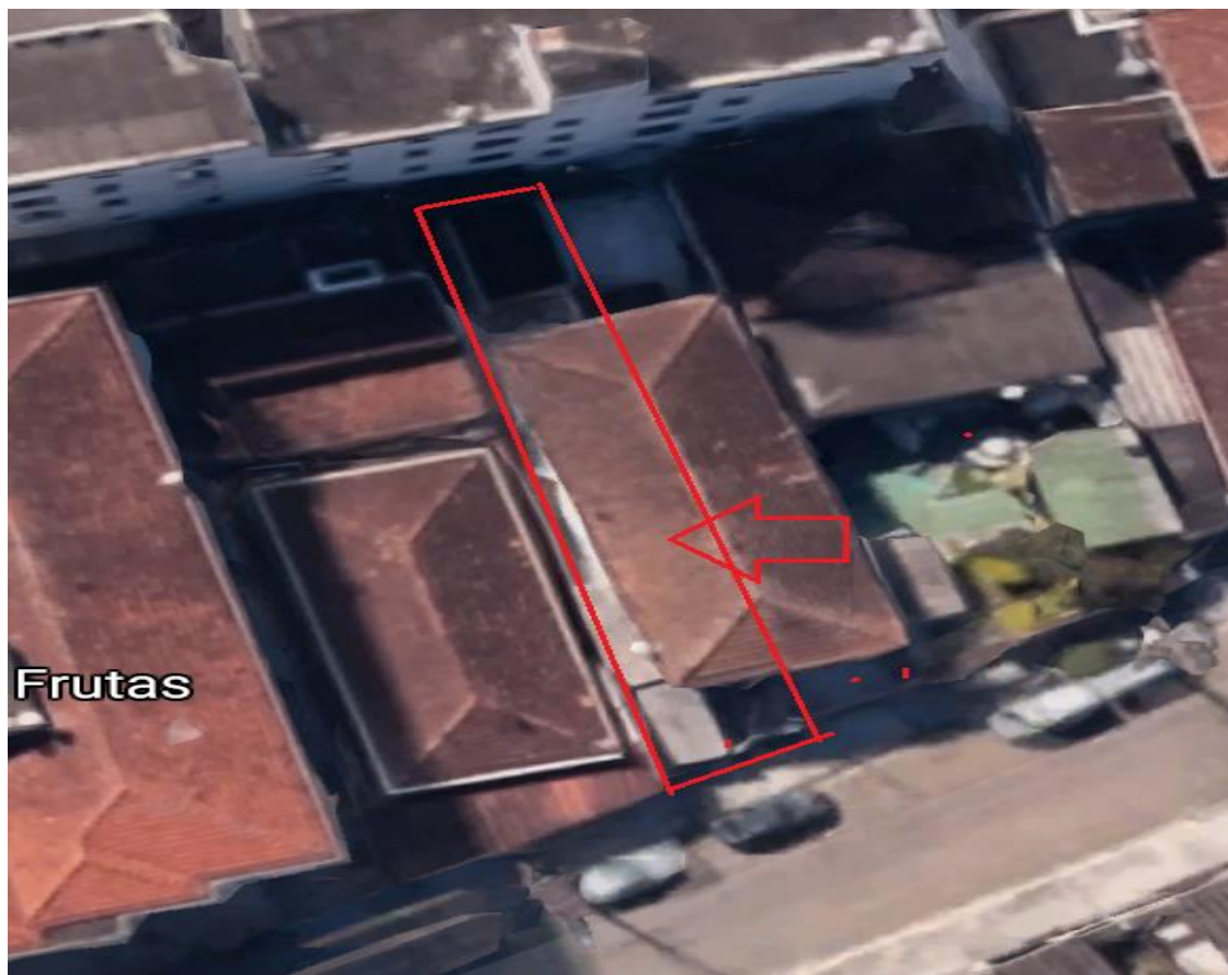
Vista parcial aérea da Quadra nº 02 e o Lote nº 03 com seus limites e confrontantes e as construções existentes.
