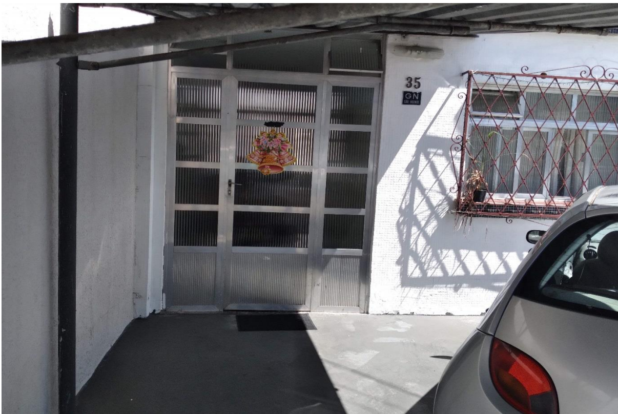
FOTO 02 - Vista parcial da fachada interna e identificação do imóvel avaliando.
