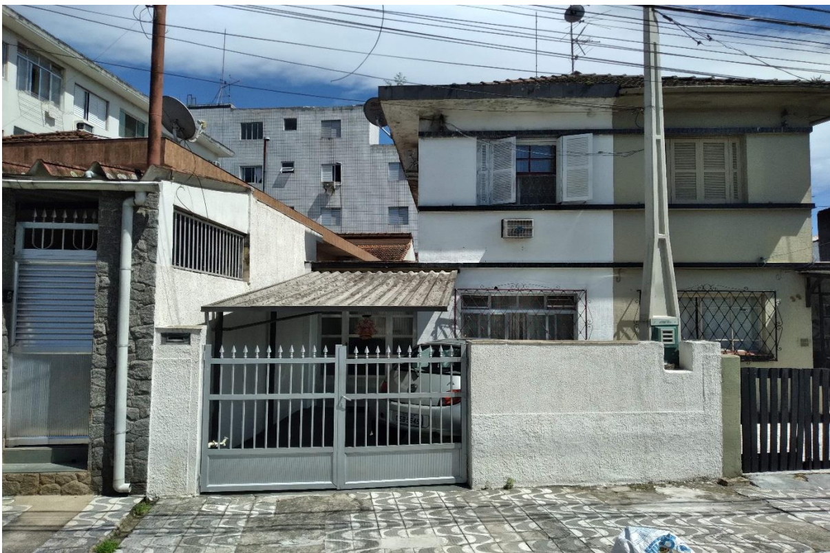
FOTO 01 - Vista parcial da fachada frontal do imóvel avaliando
