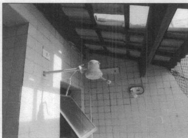
Foto 12, 13 e 14 – Vista da cobertura, com área da churrasqueira e chuveiro.
