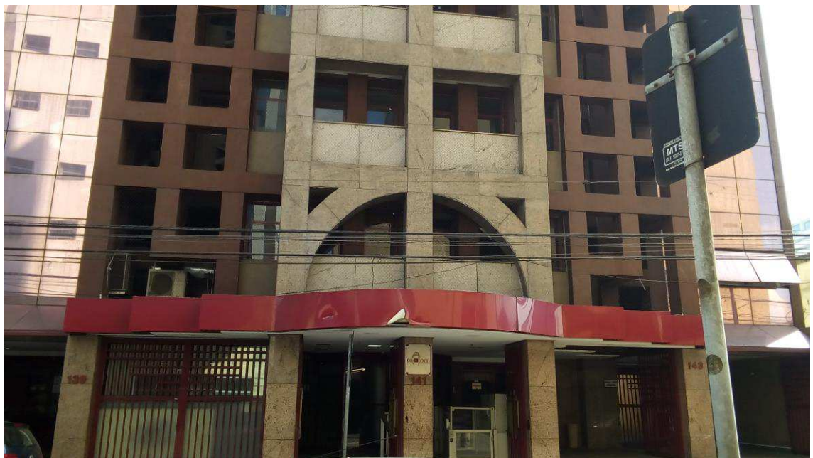
Imagem 2: Vista em frente ao imóvel periciado
