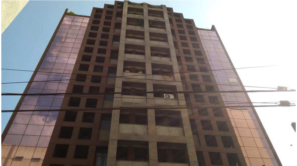
Imagem 5: Fachada do prédio
