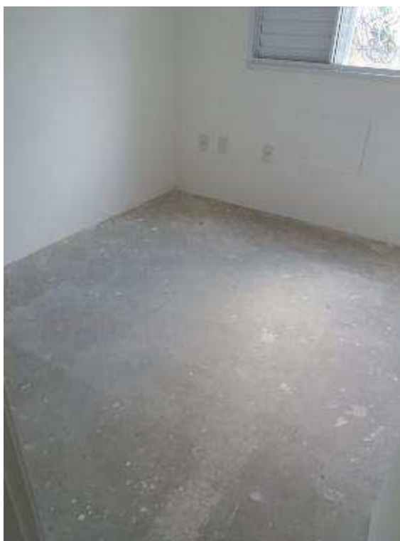
FOTO 07: - Vista do dormitório 2 do imóvel semelhante.
