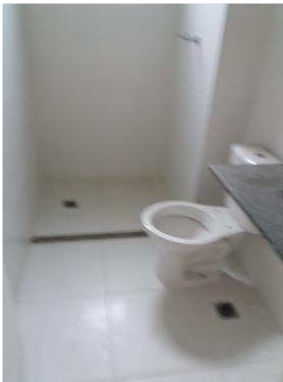
FOTO 06: - Vista do banheiro social do imóvel semelhante.
