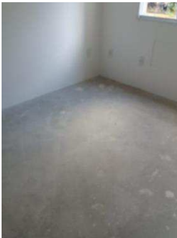
FOTO 05: - Vista do dormitório 1 do imóvel semelhante.
