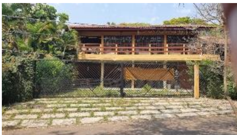
frente do imóvel (edificação)– Avenida das Perdizes
