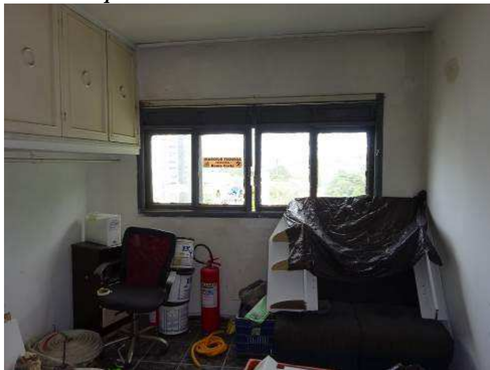
FOTO 2: Vista parcial do dormitório do imóvel avaliando.
