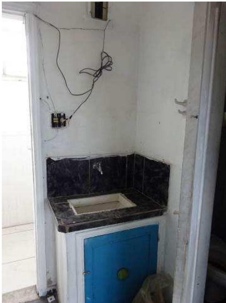
FOTO 4: Vista da cozinheira do imóvel avaliando.
