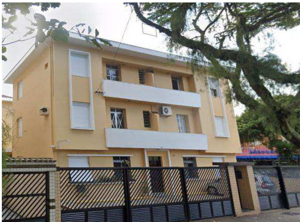
Acima, temos uma tomada da testada do Condomínio Edifício Benjamin Constant.
