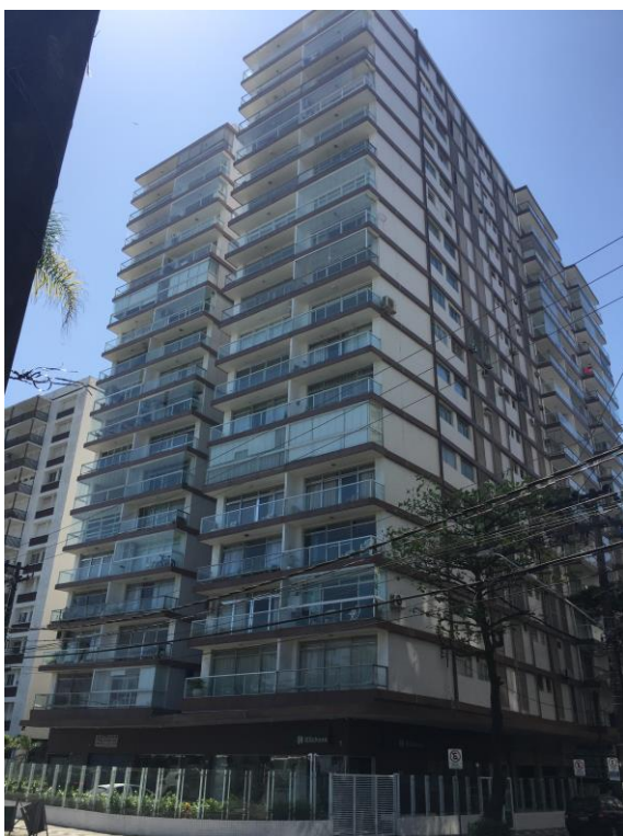
Figura 2: Vista geral do imóvel.
