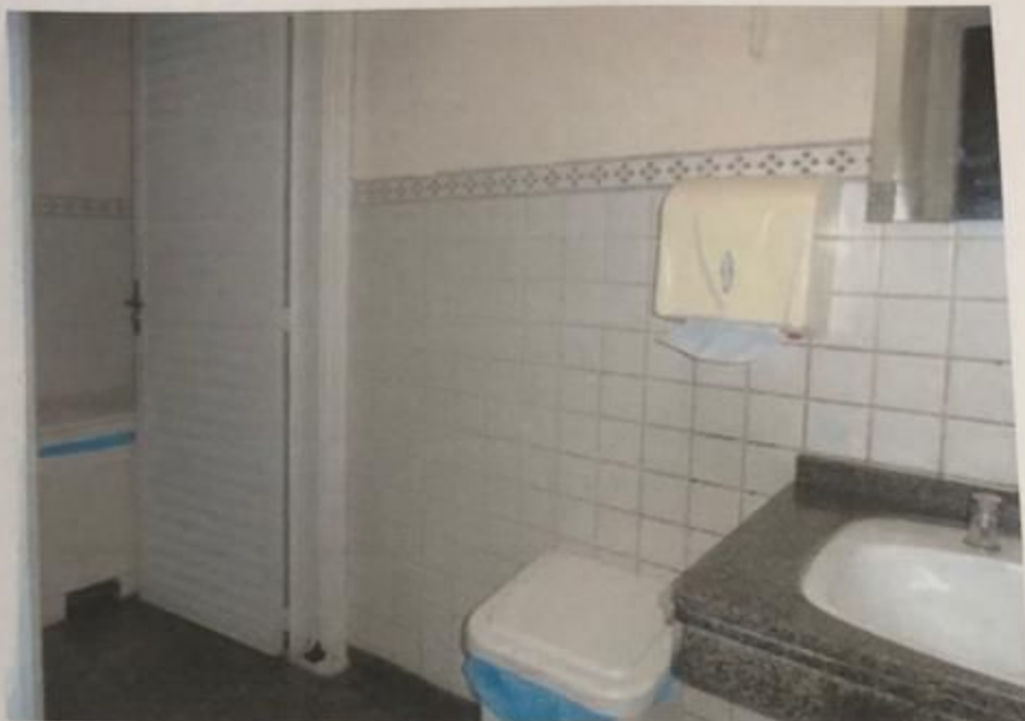
FOTO 07:- Vista do banheiro do restaurante.
