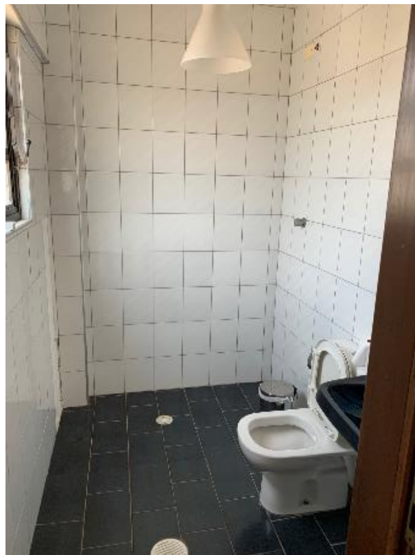
IMAGEM 10 SANITÁRIO 1 DO 1º PISO
