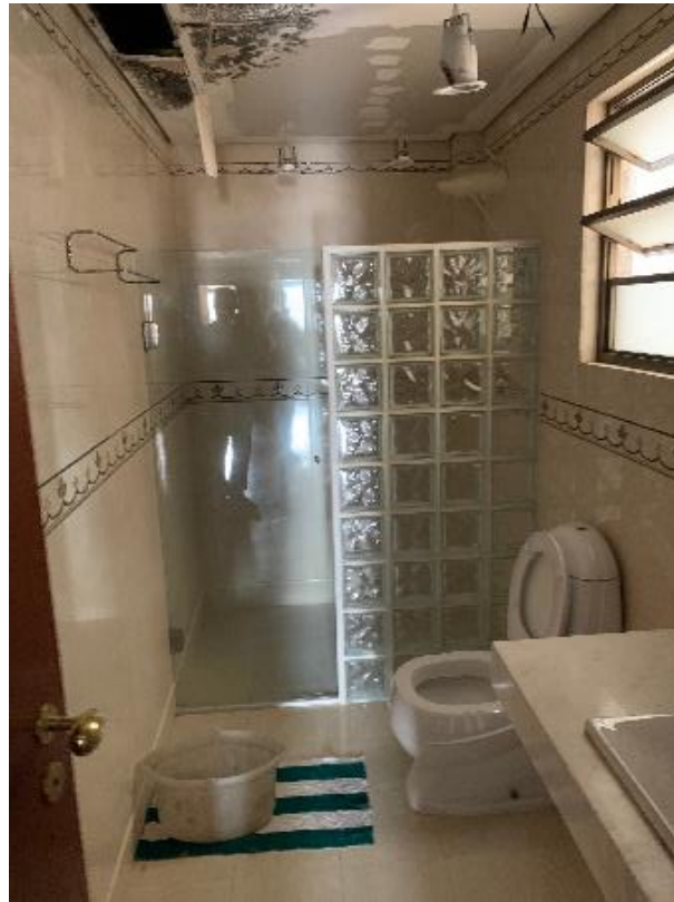
IMAGEM 11 SANITÁRIO 2 DO 1º PISO
