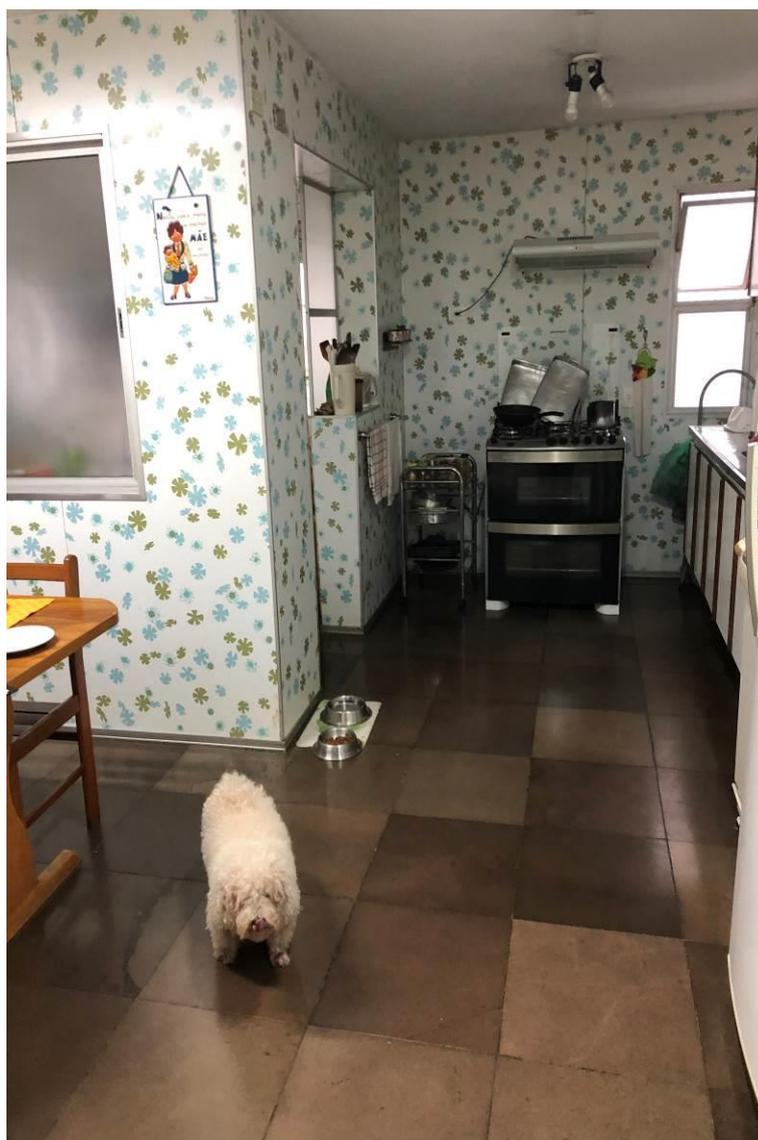
**FOTO 6** – Vista da cozinha. Suas principais características construtivas são: piso cerâmico, paredes azulejadas até o teto, forro em laje.
