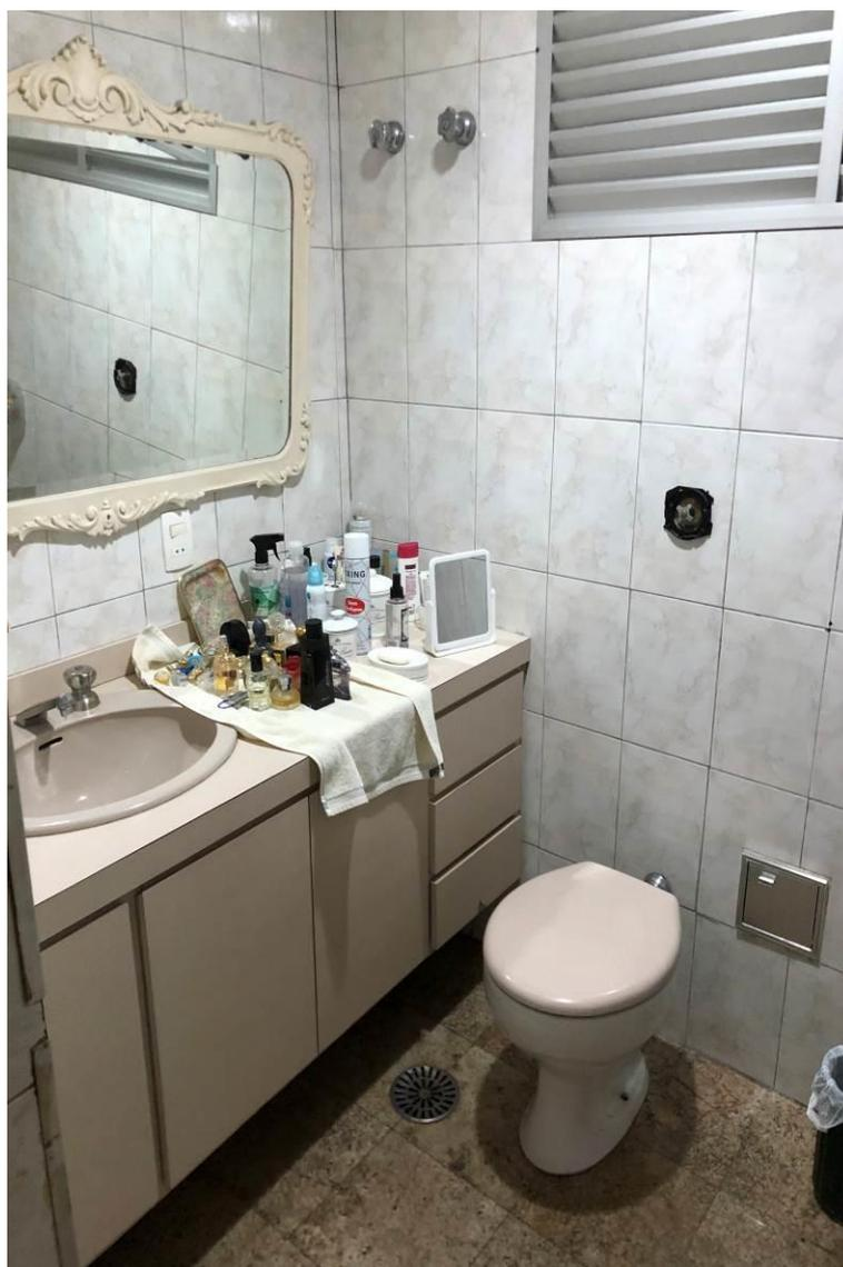
**FOTO 9** – Vista do banheiro. Suas principais características construtivas são: piso cerâmico, paredes azulejadas até o teto, forro em laje e esquadrias de alumínio.
