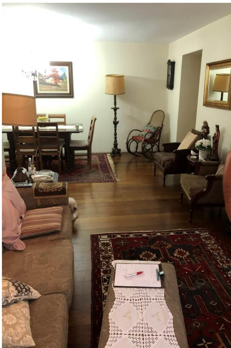
**FOTO 8** – Vista da sala. Suas principais características construtivas são: piso em assoalho de madeira, paredes revestidas em massa corrida pintadas em látex, forro em laje
