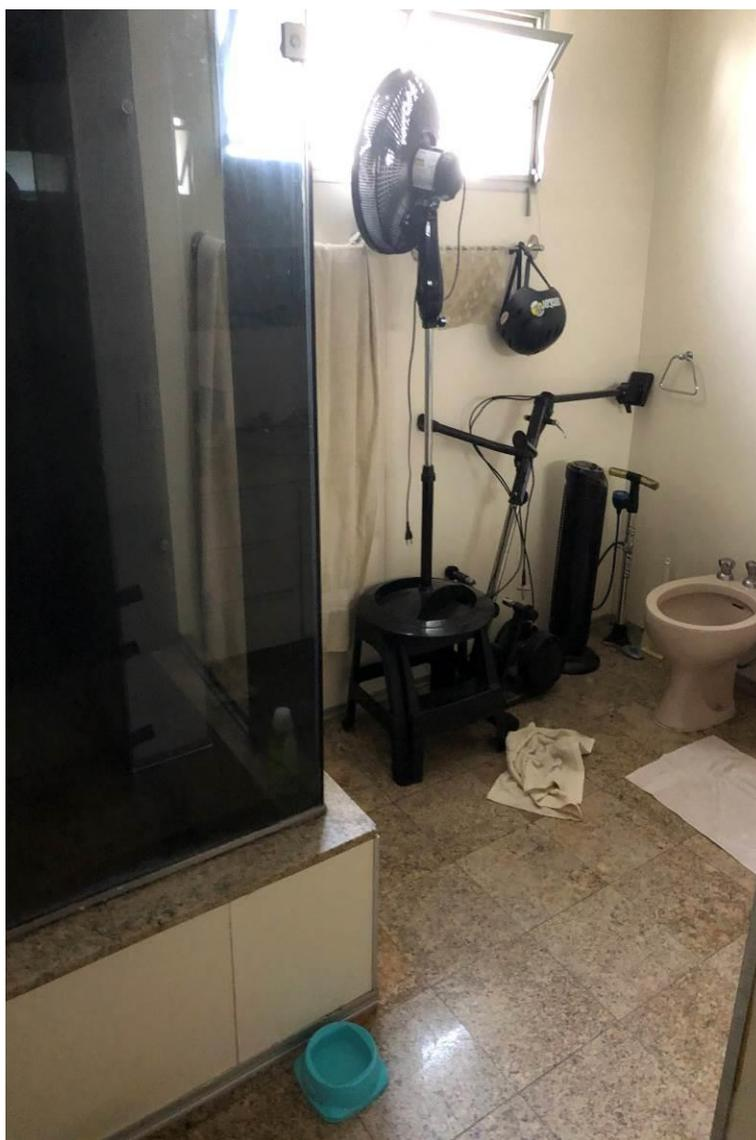
**FOTO 11** – Vista do banheiro. Suas principais características construtivas são: piso cerâmico, paredes azulejadas até o teto, forro em laje e esquadrias de alumínio.
