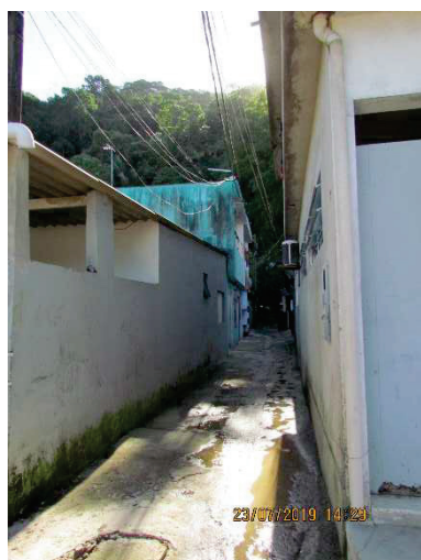
Corredor entre casas que vão em direção á encosta do imóvel
