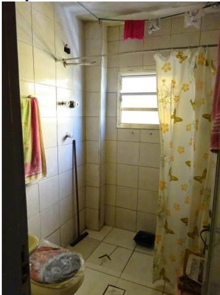
FOTO 5: Vista parcial do banheiro do imóvel avaliando.
