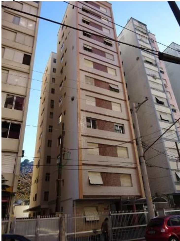
FOTO 1: Vista da fachada frontal e lateral esquerda do edifício Maracá.
