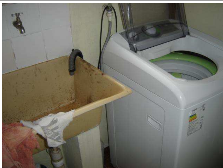
Imagens Área de Serviço
