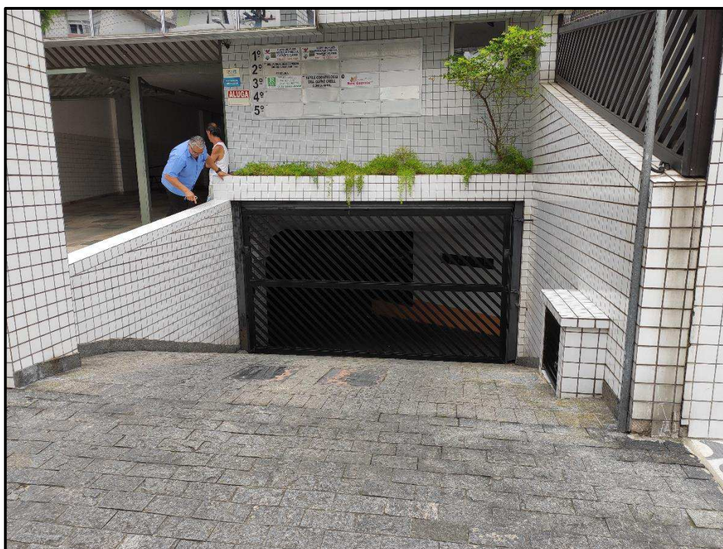
Foto 5: Área Comum – Vista do acesso ao estacionamento no subsolo
