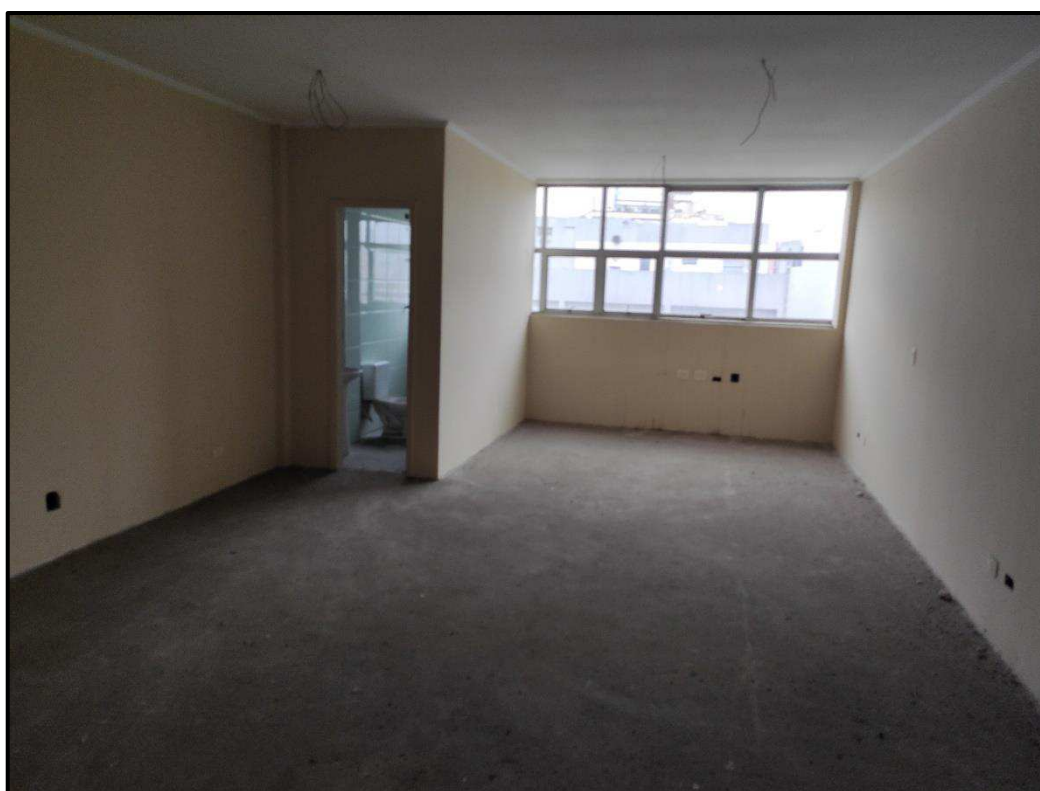
Foto 19: Vista interna do imóvel – Sala andar inferior (5º pavimento)
