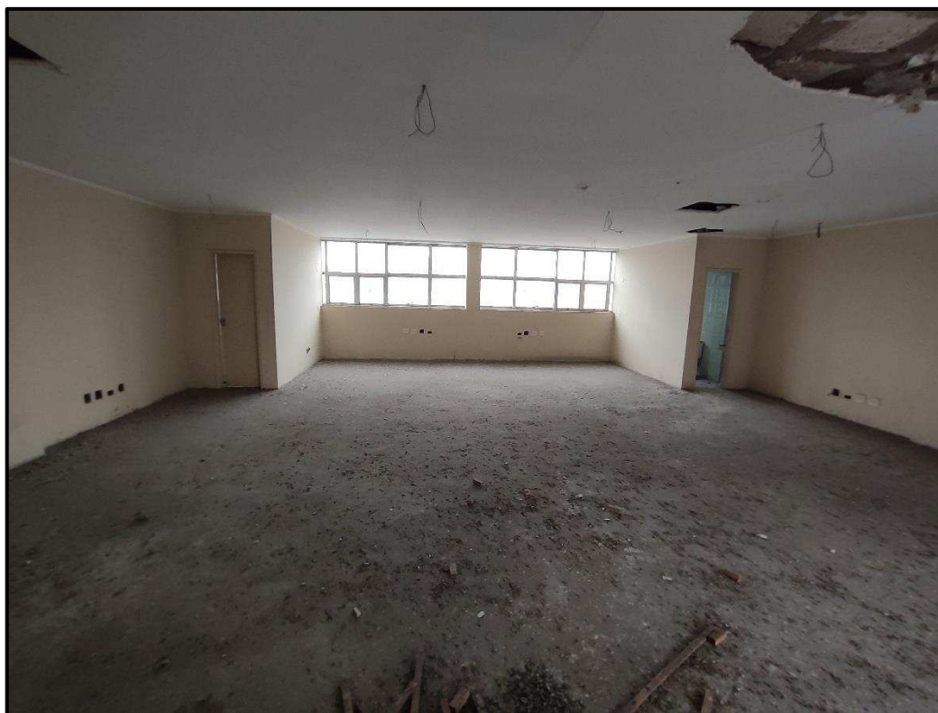
Foto 26: Vista interna do imóvel – Sala do piso superior (6º pavimento)
