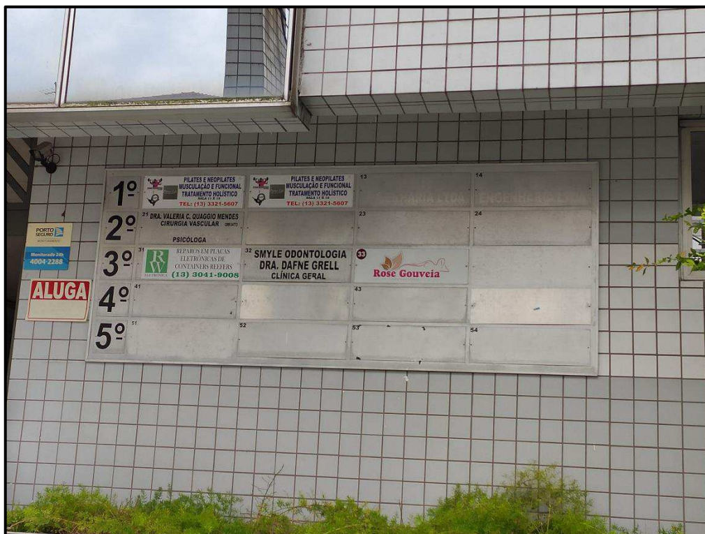
Foto 2: Fachada do Condomínio Edifício Carlos Chagas, Rua Monsenhor de Paula Rodrigues, número predial 92, Vila Belmiro, Município de Santos - SP.
