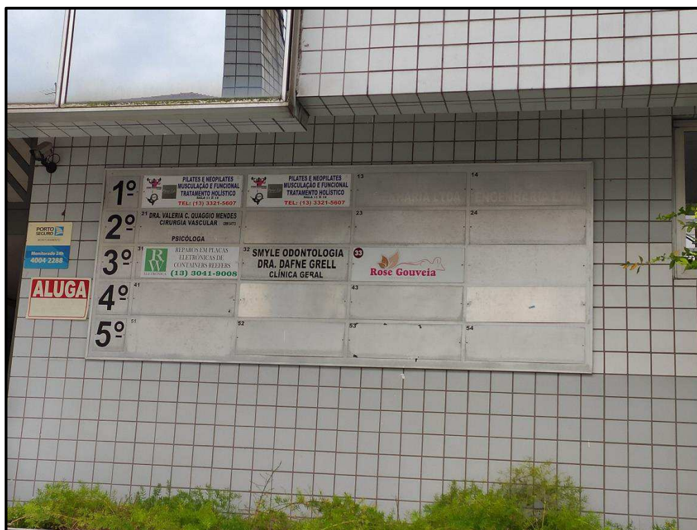
Foto 2: Fachada do Condomínio Edifício Carlos Chagas, Rua Monsenhor de Paula Rodrigues, número predial 92, Vila Belmiro, Município de Santos - SP.
