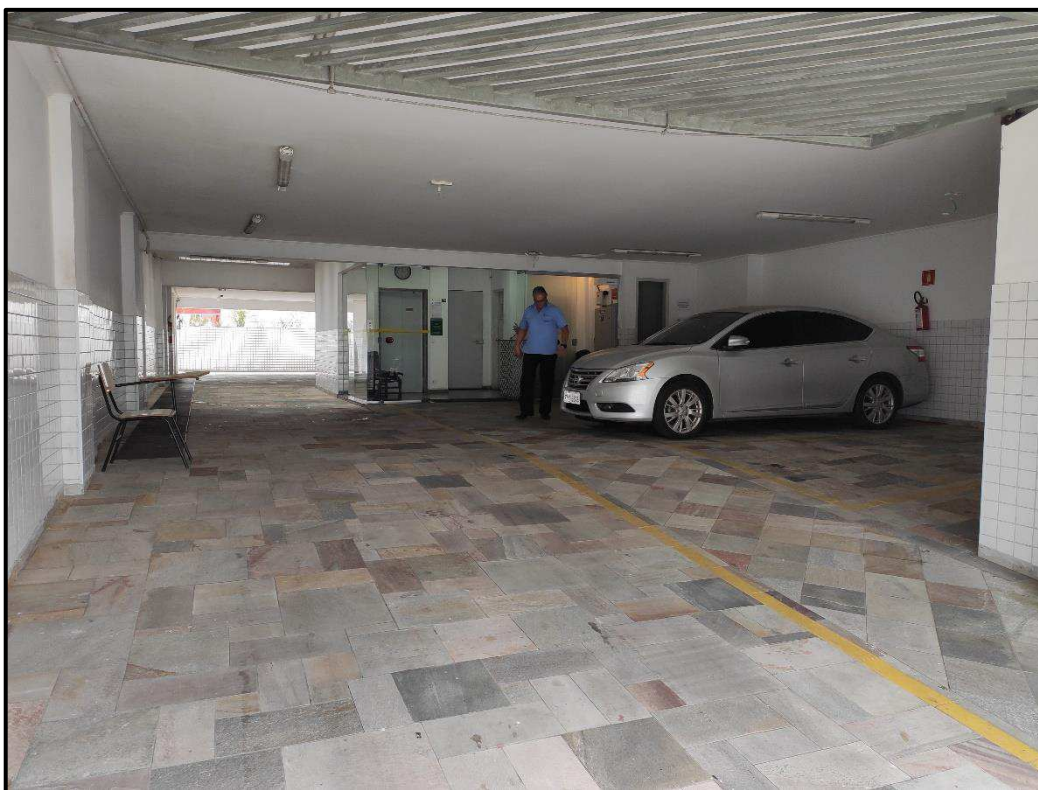
Foto 6: Área Comum – Vista do acesso ao estacionamento do térreo
